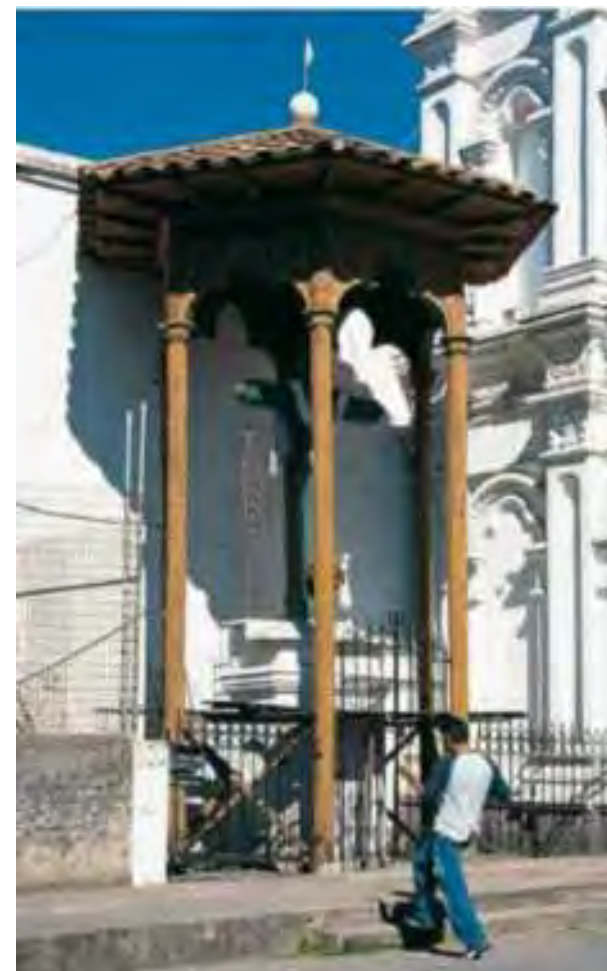
Fig. 27 Cruz de Todos Santos. Fuente: Junta de Andalucía y La Ilustre Municipalidad de Cuenca. (2007). Guía de arquitectura. Cuenca Ecuador. Junta de Andalucía, Consejería de Obras Públicas y Transportes Dirección General de Arquitectura y Vivienda, Fomento de la Arquitectura. https://www.juntadeandalucia.es/fomento-y-vivienda/estaticas/sites/consejeria/areas/arquitectura/fomento/guias_arquitectura/adjuntos_ga/Cuenca_e.pdf
