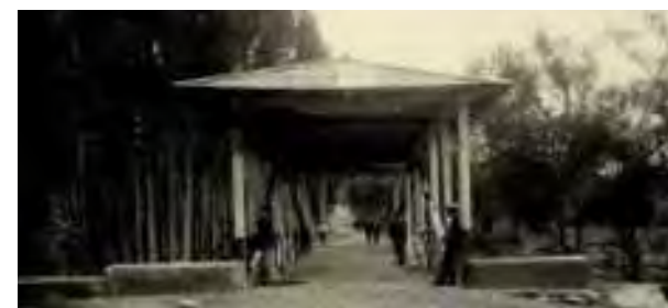
Fig. 49 Puente Ingachaca. Fuente: Manuel Jesús Serrano 1920
