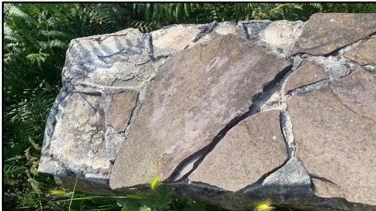
*Ilustración 40: Estado de las losas del murete*
