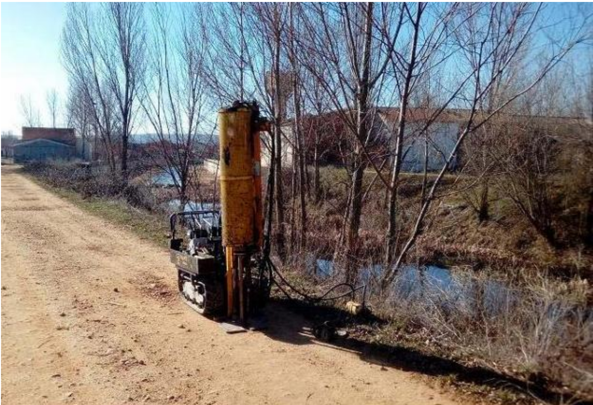
Ilustración 3 Maquina instalada para la penetración dinámica
