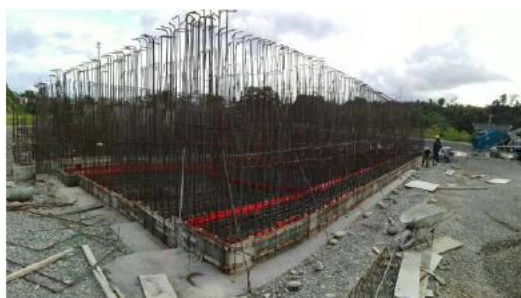
Foto 3: Trabajos en PTAP de Itsmina
