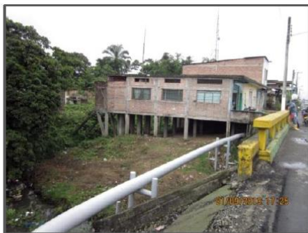
Fotografía 1: Tubería de petróleo bajo las casas
