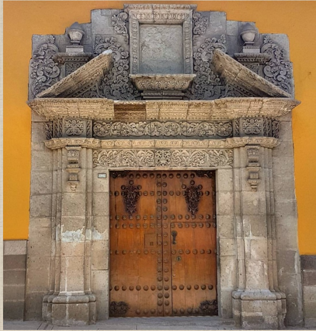
Fig. 75 Fachada, Casona Espinach.
