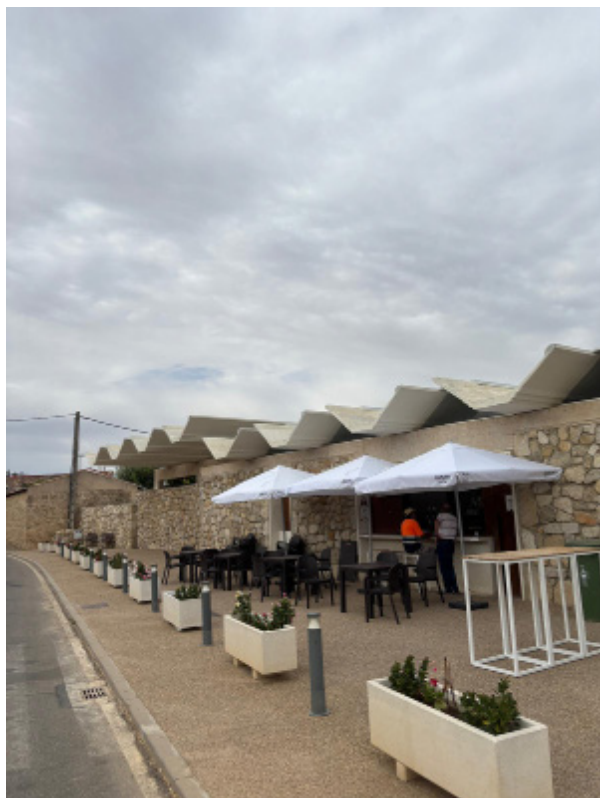
Figura 4.81. Exterior del bar de las piscinas de Castromonte
