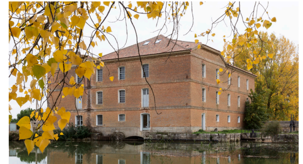
Figura 6.16. Fábrica del canal de Castilla
