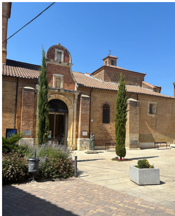
Figura 5.8. Iglesia en Saldaña que alberga el museo de la villa
