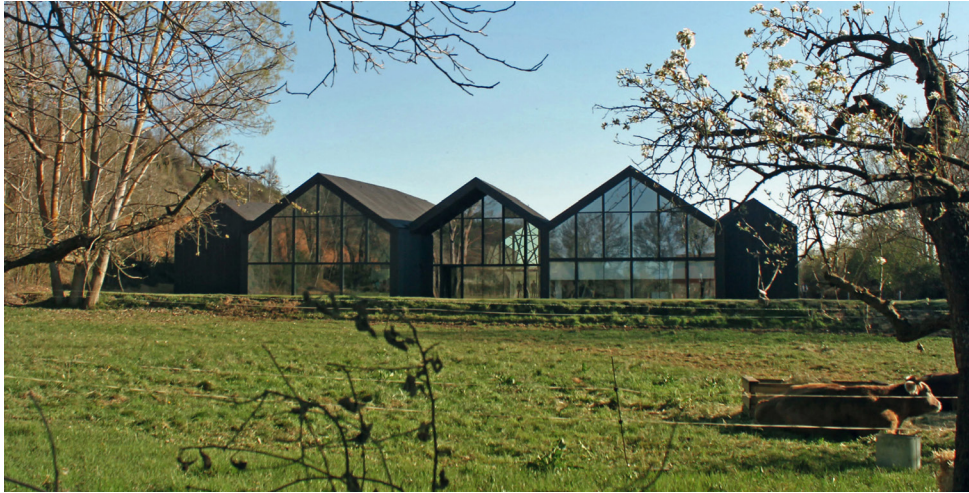
Figura 4.21. Acceso exterior a la fundación
