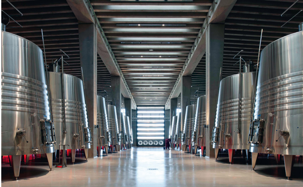
Figura 4.2. Interior de la bodega
