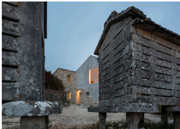
Figura 2.14. Rehabilitación vivienda unifamiliar
