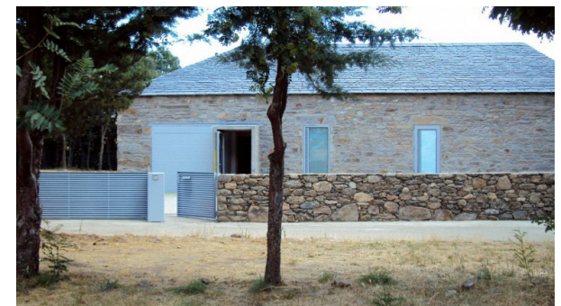
Figura 6.42. Centro multiservicios en Puente de Sanabria
