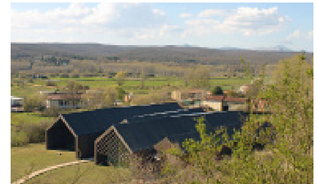
Figura 4.32. Foto aérea exterior
