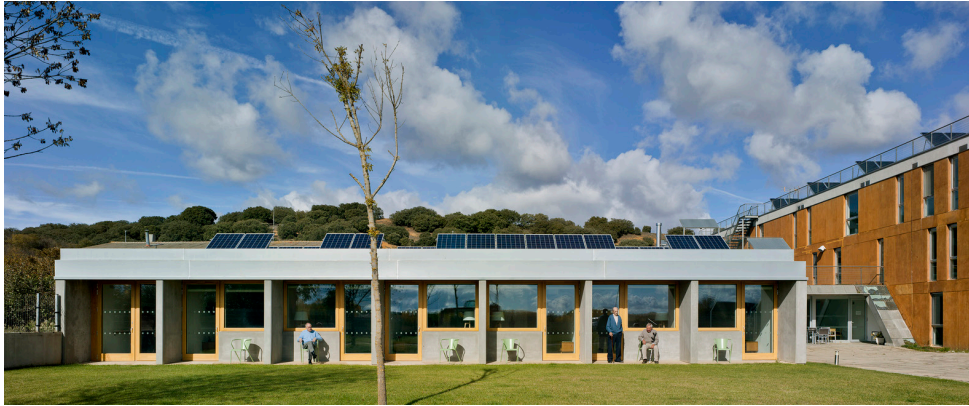
Figura 4.84. Fachada hacia uno de los patios
