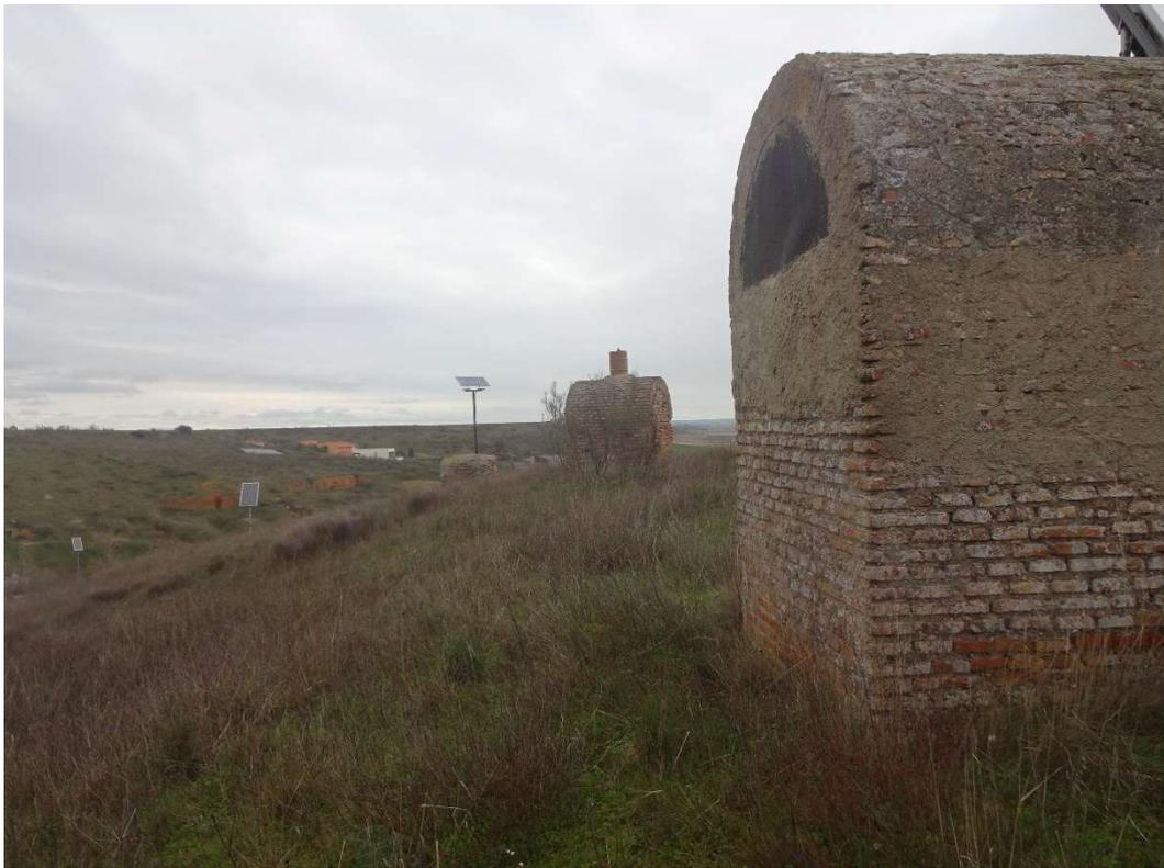
**Fig.19.** Coronación final de las zarceras para controlar la ventilación de la bodega y evitar la entrada de agua evitando la erosión.
