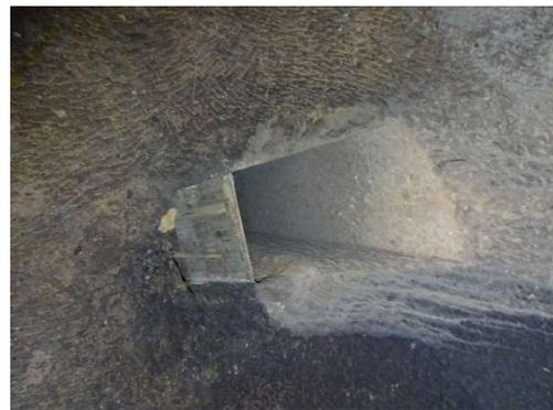
Fig.5-6. Marcas, “picotadas”, de las herramientas utilizadas para la excavación de las bodegas.
