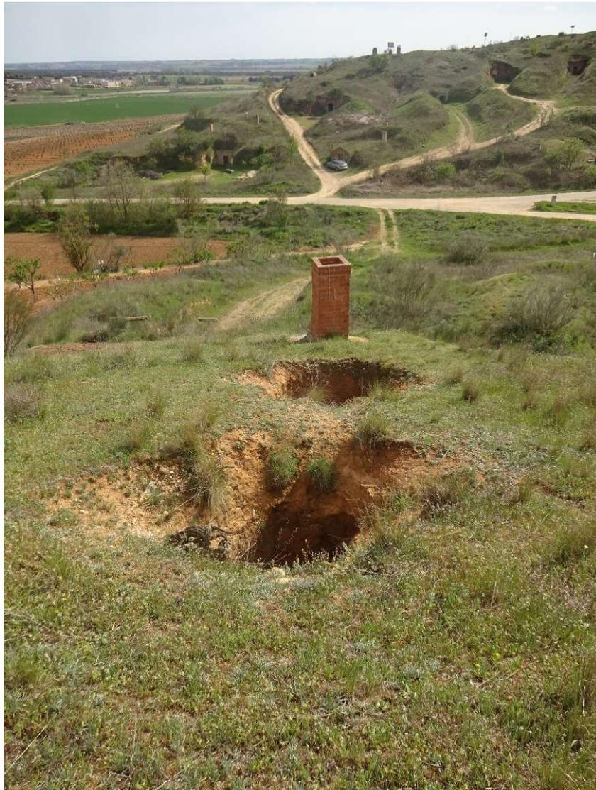
**Fig.7.** Imagen de la parte superior de una bodega con una zarcera (chimenea) en buen estado y dos zarceras colapsadas.
