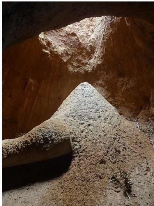
**Fig.59.** Zarcera colapsada con forma de "reloj de arena" en la bodega SRH\_B21.
