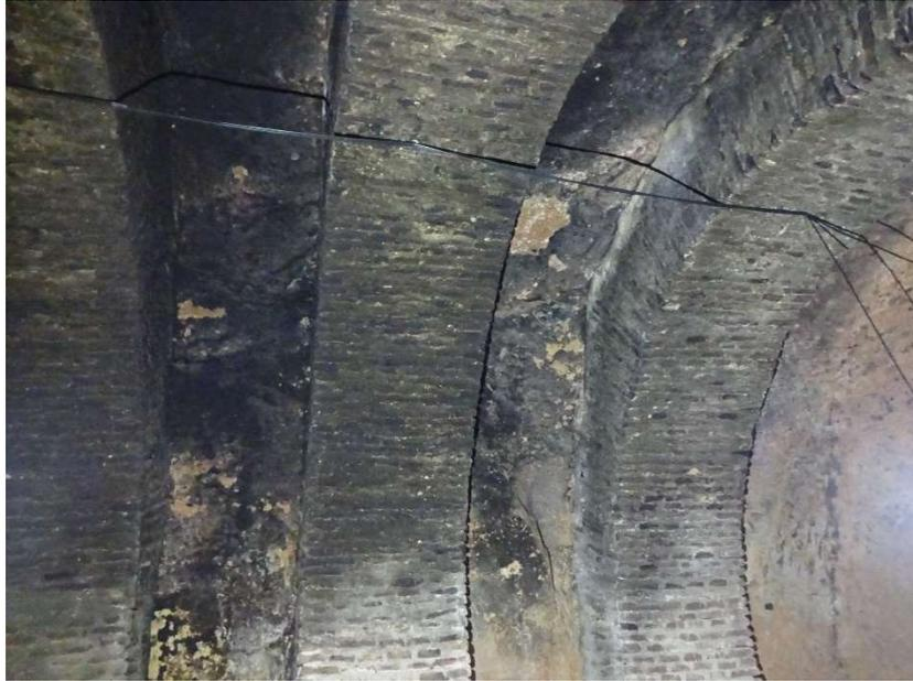
**Fig.58.** Arcos de refuerzo estructural en la bodega SRH\_B20.
