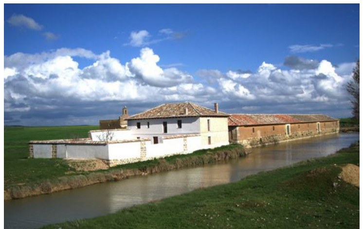
Conjunto después de la rehabilitación (2001) © Asensi, José M a (2019, 15 de julio)
