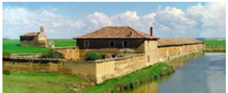
Conjunto antes de la rehabilitación (1999) © Asensi, José M a (2019, 15 de julio)
