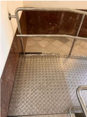
Figura 134 Rampa R1A acceso 1.
