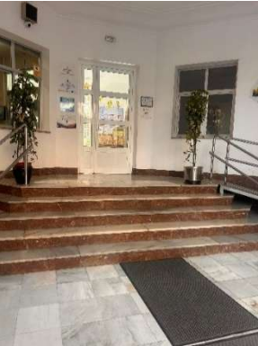
Figura 132 Escaleras EB1 acceso 1
