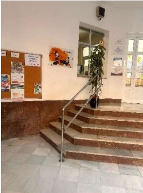
Figura 131 Escaleras EB1 acceso 1
