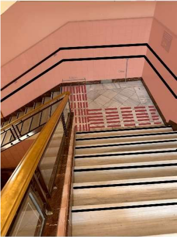
Figura 274 Escalera 3, Itinerario 4, meseta.
