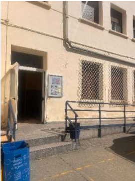
Figura 228 Rampa R5A Itinerario 5.
