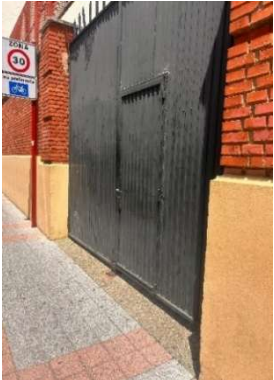
Figura 225 Puerta de acceso P2A itinerario 2.
