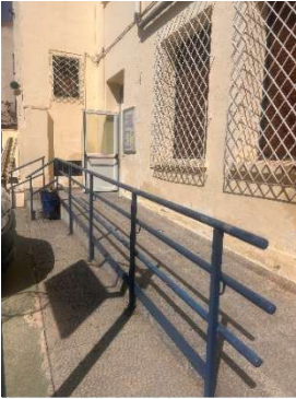
Figura 226 Rampa R5A itinerario 5.
