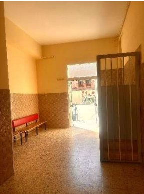
Figura 234 Itinerario horizontal S5A acceso 5.
