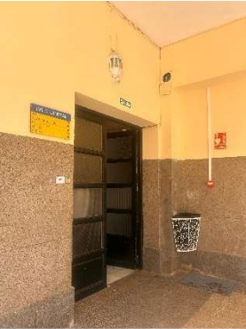
Figura 190 Puerta P3B Itinerario 3.
