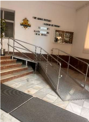
Figura 136 Rampa R1A acceso 1.
