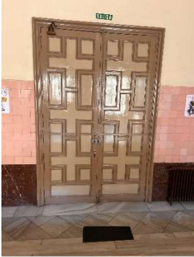
Figura 211 Puerta P4A acceso 4. Interior.
