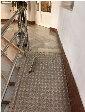
Figura 135 Rampa R1A acceso 1.
