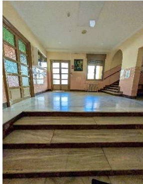
Figura 215 Distribuidor horizontal S4A it. 4 y escaleras E4A.
