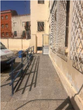
Figura 227 Rampa R5A Itinerario 5.
