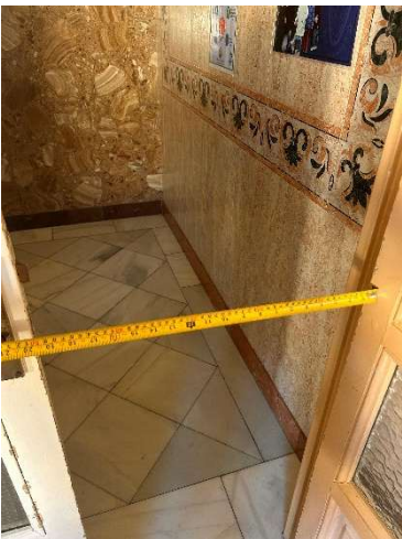
Figura 277 Puerta de escalera 2. Primera planta. Ancho de paso.
