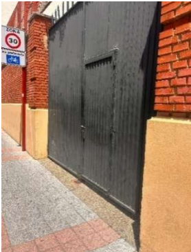
Figura 154 Puerta de acceso P2A.
