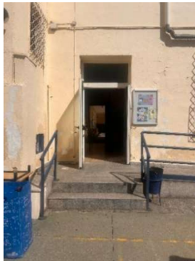
Figura 223 Escalera exterior E2A itinerario 2
