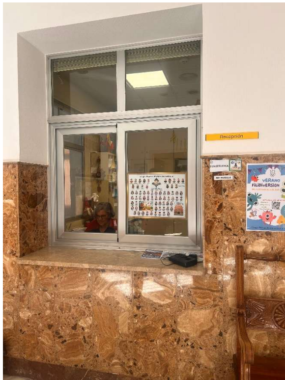
Figura 265 Planta baja, mostrador de atención al público.
