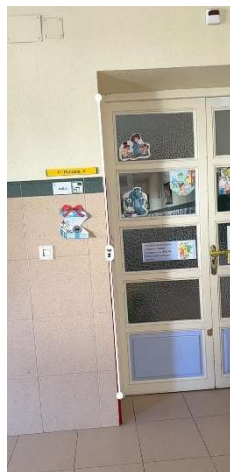
Figura 279 Puerta de 1º de primaria A. Primera planta.
