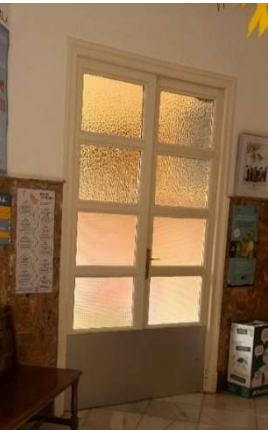
Figura 145 Puerta P1C acceso 1.
