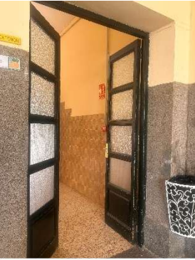
Figura 233 Puerta P5B itinerario 5.
