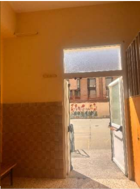
Figura 235 Itinerario horizontal S2A acceso 2.
