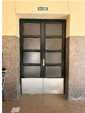
Figura 150 Puerta P1D acceso 1.
