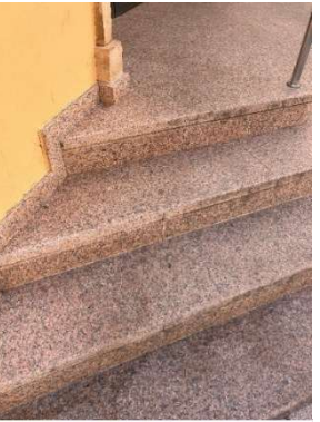
Figura 127 Escaleras exteriores acceso 1.
