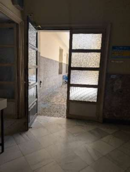
Figura 192 Puerta P3B Itinerario 3.
