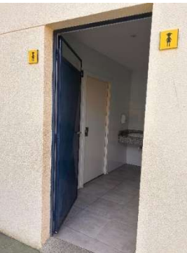
Figura 174 Aseo accesible patio exterior puerta exterior.
