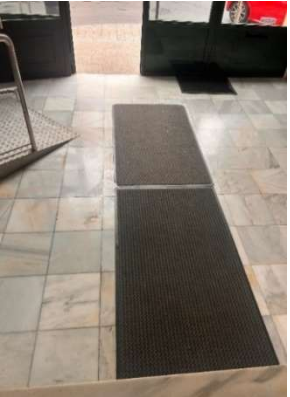
Figura 130 Vestíbulo de entrada acceso 1.
