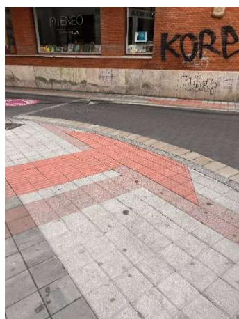
Figura 19 Detalle - 1 – Cruce calle Padre H. Aparicio.
