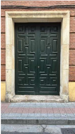
Figura 210 Puerta P4A acceso 4. Exterior.
