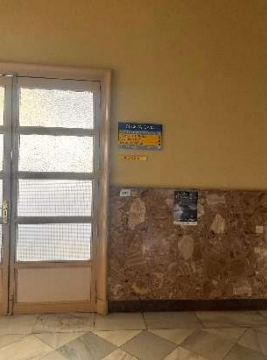
Figura 191 Puerta P3B Itinerario 3.
