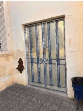
Figura 157 Puerta P2B itinerario 2.
