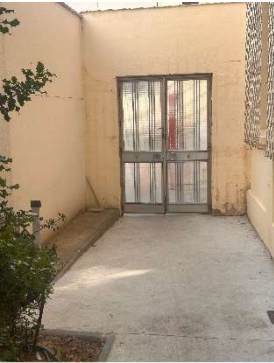
Figura 155 Puerta P2B itinerario 2.
