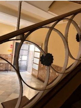
Figura 201 Escaleras 2 despl. vertical.
