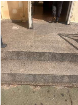
Figura 224 Escalera exterior E2A Itinerario 2.
