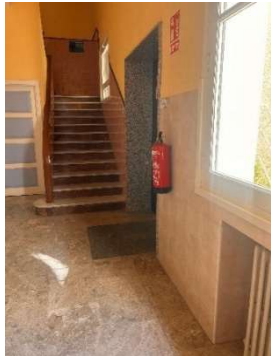
Figura 175 Escalera 1 espacio previo
