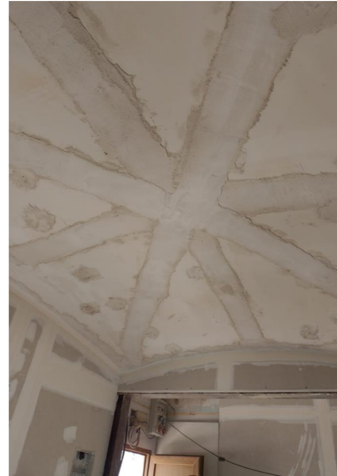
Refuerzo en la bóveda tras la redistribución de la vivienda
