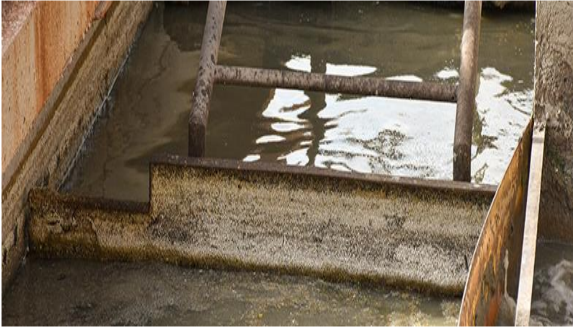
Figura 2. Sedimentador primario en una EDAR [9]
