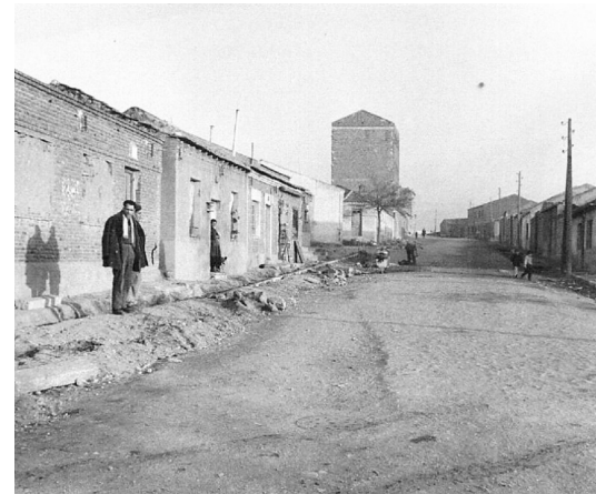
Obras de urbanización en Pajarillos Altos cuando el barrio aún estaba sin pavimentar, en una fecha desconocida seguramente anterior a los años 60. ARCHIVO MUNICIPAL.
