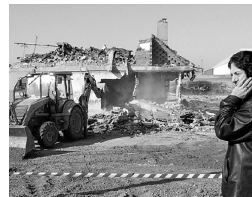
Figura 34. Demolición de la última casa del Poblado de la Esperanza (2003). El diario de Valladolid
