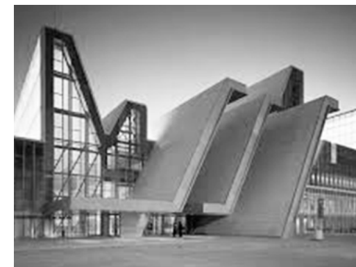
Figura 8. Exterior palacio de congresos. Arquitectura Viva
