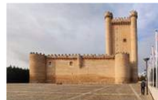
Fig. 03. Castillo de Fuensaldaña, Valladolid. Imagen del autor.
