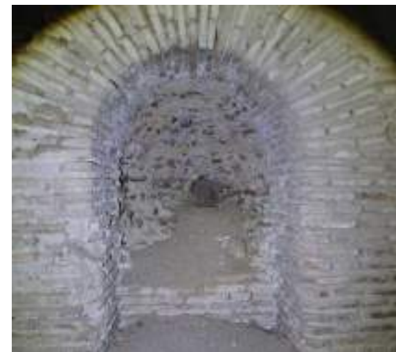
Fig. 75. Cimentación de la torre circular Sur vista desde las galerías subterráneas de la fortaleza de Castronuevo, Ávila. Imagen del autor.
