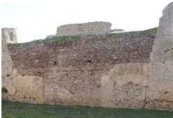
Fig. 84. Fotografía del tramo de muro de mampostería del recinto interior de la fortaleza de Castronuevo, Ávila. Imagen del autor.
