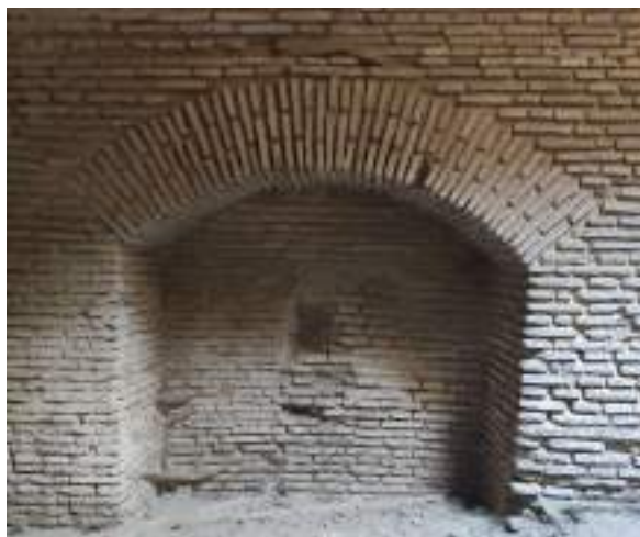
Fig. 56. Arcos interiores de las galerías subterráneas de Castronuevo, Ávila. Imagen del autor.
