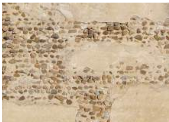
Fig. 71. Revestimiento a modo de enfoscado de cal sobre el cuerpo inferior del lienzo Sur de la barrera artillera de la fortaleza de Castronuevo, Ávila. Imagen del autor.
