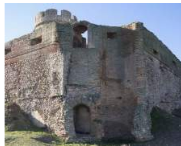
Fig. 15. Cubo Norte inconcluso de la barrera artillera de Castronuevo, Ávila. Imagen del autor.
