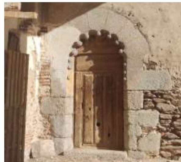
Fig. 35. Puerta con decoración de bolas en la planta baja del palacio de Castronuevo, Ávila. Imagen del autor.
