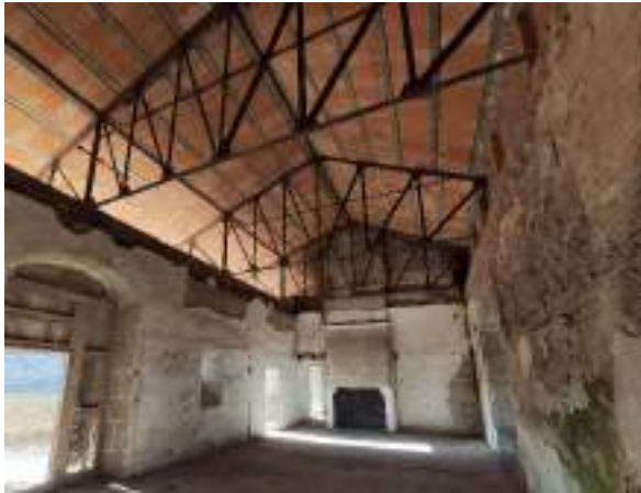
Fig. 40. Fotografía desde el salón principal de la planta primera a la estructura actual de cerchas metálicas de la cubierta palacio de Castronuevo, Ávila. Imagen del autor.
