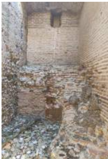
Fig. 46. Fotografía desde el interior de las escaleras de la torre del homenaje de Castronuevo, Ávila. Se aprecia como el muro de ladrillos y el de tapial no están trabados entre sí. Imagen del autor.
