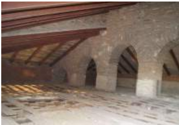
Fig. 64. Fotografía de las vigas metálicas y rasillones cerámicos que configuran la pendiente de la esquina noreste de la cubierta del palacio de Castronuevo, Ávila. Imagen del autor.
