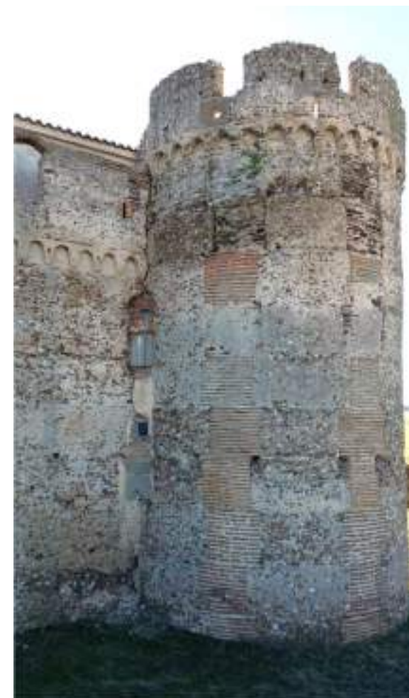
Fig. 72. Torre construida en hiladas horizontales mediante machones de ladrillo (en los niveles superiores con mampostería de piedra) y tapial de cal y canto, situada en el ángulo Oeste del recinto interior de la fortaleza de Castronuevo, Ávila. Imagen del autor.
