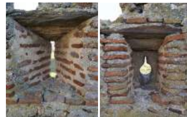
Fig. 27. y Fig. 28. Troneras presentes en las torres y el almenado de la fortaleza de Castronuevo, Ávila. Imagen del autor.
