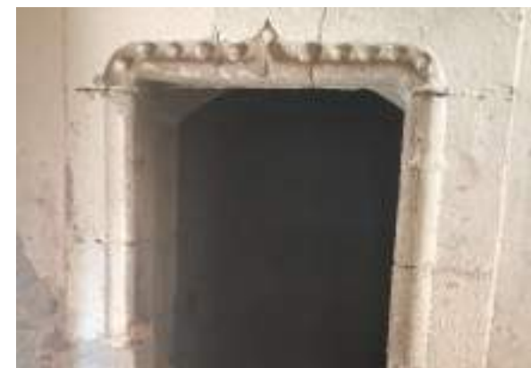
Fig. 36. Puerta con decoración de bolas en la planta baja del palacio de Castronuevo, Ávila. Imagen del autor.
