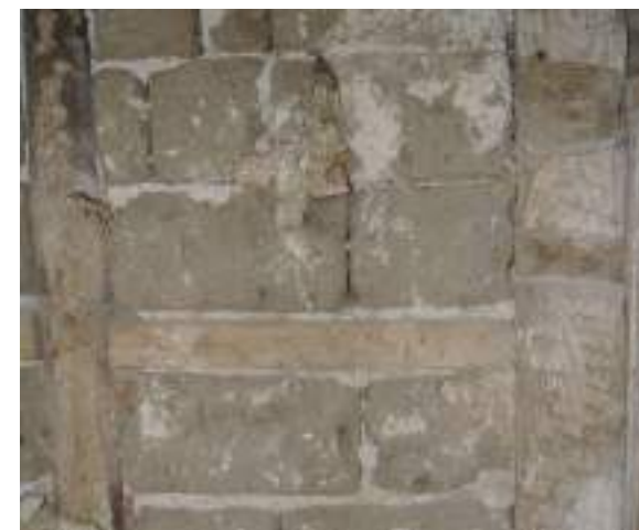
Fig. 66. Muro de adobe y madera en la planta de servicio del palacio de Castronuevo, Ávila. Imagen del autor.
