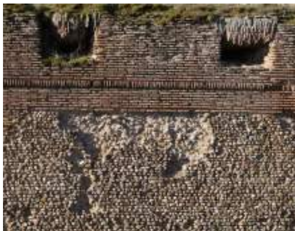
Fig. 78. Barrera artillera, desde su lado Este, de la fortaleza de Castronuevo, Ávila. Imagen del autor.
