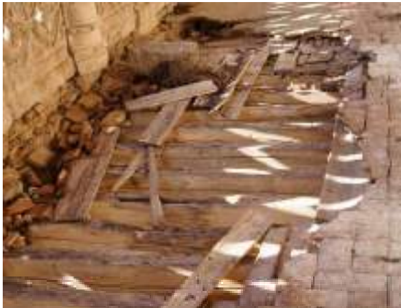
Fig. 41. Forjado de la galería de acceso al palacio de Castronuevo, Ávila. Imagen del autor.
