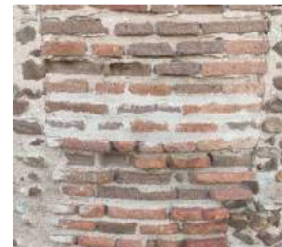
Fig. 95. Machón inferior de fábrica de ladrillo de la torre circular Norte de la fortaleza de Castronuevo, Ávila. Imagen del autor.
