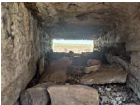
Fig. 53. Tronera de buzón desde el interior de la barrera artillera de Castronuevo, Ávila. Imagen del autor.
