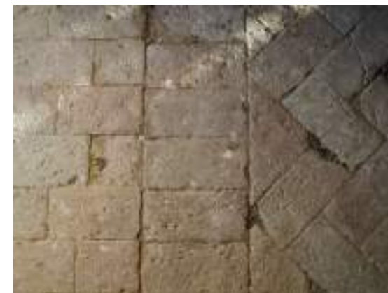
Fig. 94. Encuentro entre varios pavimentos de ladrillo de tejar de la Planta Primera del palacio de Castronuevo, Ávila. Imagen del autor.
