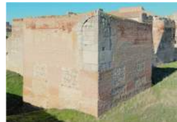
Fig. 44. Torre del homenaje inacabada de Castronuevo, Ávila. Imagen del autor.
