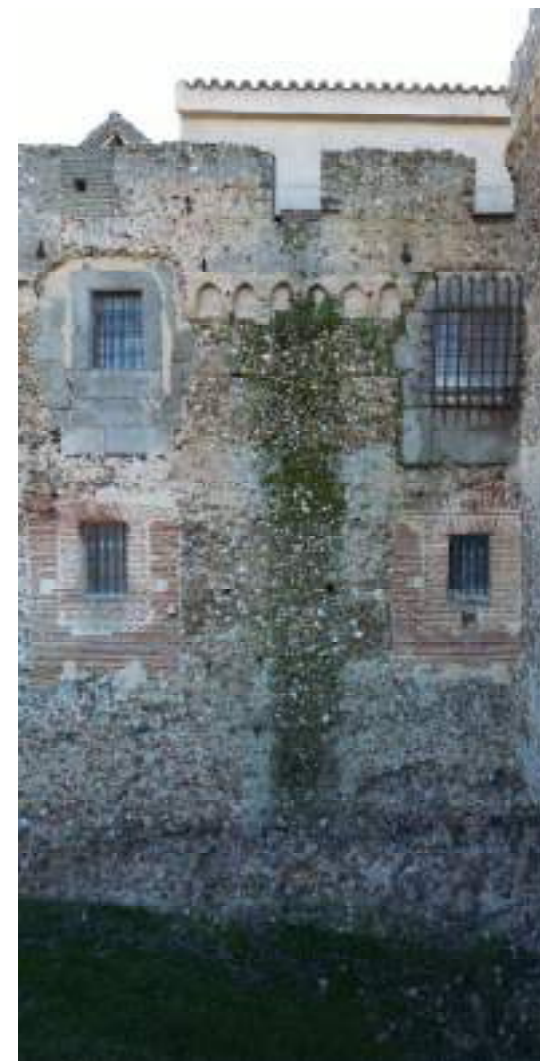
Fig. 105. Lavado diferencial sobre el lienzo Norte del recinto interior de la fortaleza de Castronuevo, Ávila. Imagen del autor.
