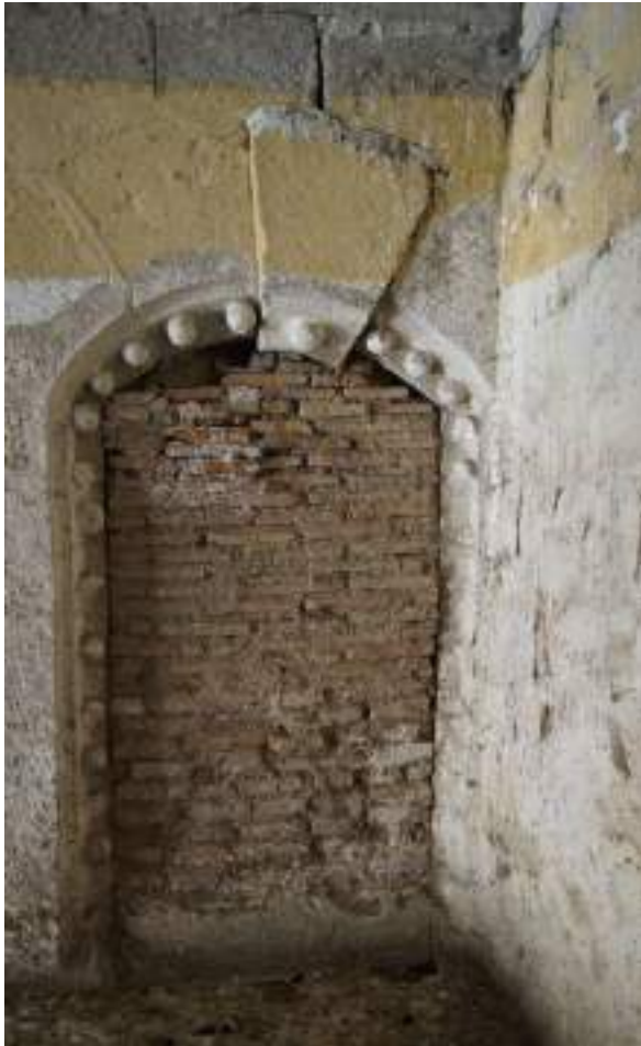
Fig. 67. Encalado de cal sobre los muros de sillería granítica (izquierda) y revestimiento de cal sobre el muro de tapial de calicanto (derecha) en el descansillo de las escaleras de acceso del palacio de Castronuevo, Ávila. Imagen del autor.
