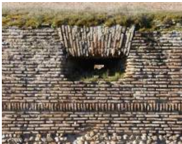
Fig. 52. Tronera de buzón desde el exterior de la barrera artillera de Castronuevo, Ávila. Imagen del autor.
