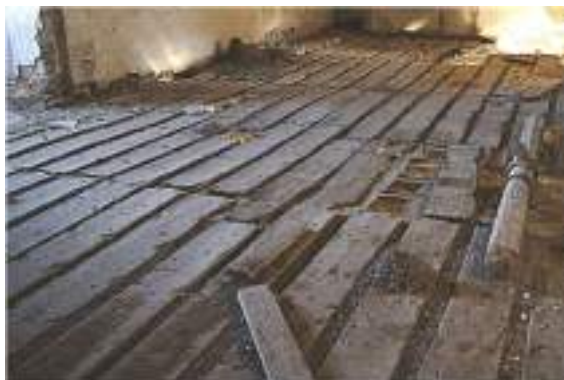
Fig. 92. Tablones de madera bajo el pavimento retirado de ladrillo (de la posible cocina) del forjado de la Planta de Servicio del palacio de Castronuevo, Ávila. Imagen del autor.
