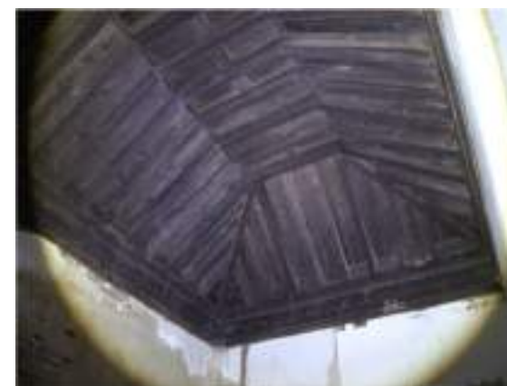
Fig. 87. Techumbre bajocubierta, posiblemente original, de la estancia Oeste de la Primera Planta del palacio de Castronuevo, Ávila. Imagen del autor.
