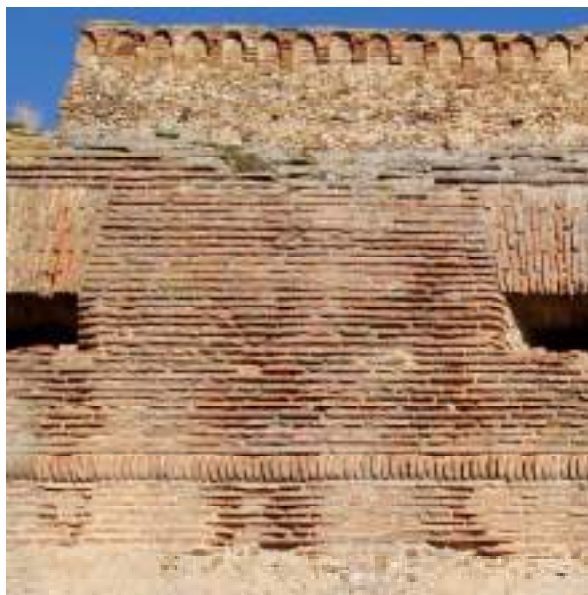
Fig. 99. Aparejo flamenco de la barrera artillera del castillo de Castronuevo, Ávila. Imagen del autor.
