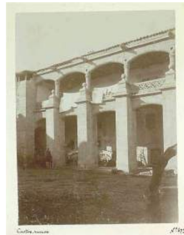
Fig. 19. Fotografía del castillo de Castronuevo desde el interior del patio de armas, donde se aprecia el estado de conservación de la galería y parte del remate del muro con la cubierta, y como el palacio es habitado por trabajadores agrícolas de la dehesa.
