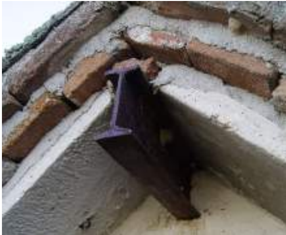
Fig. 63. Viga IPN presente en la cubierta del palacio de Castronuevo, Ávila. Imagen del autor.
