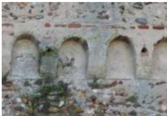
Fig. 70. Revestimiento de cal conservado sobre la línea de arquillos cegados volados bajo el almenado del recinto interior de la fortaleza de Castronuevo, Ávila. Imagen del autor.
