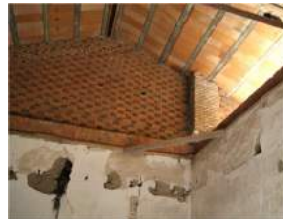
Fig. 65. Muro de ladrillo perforado sobre muro de tapial de tierra del palacio de Castronuevo, Ávila. Imagen del autor.
