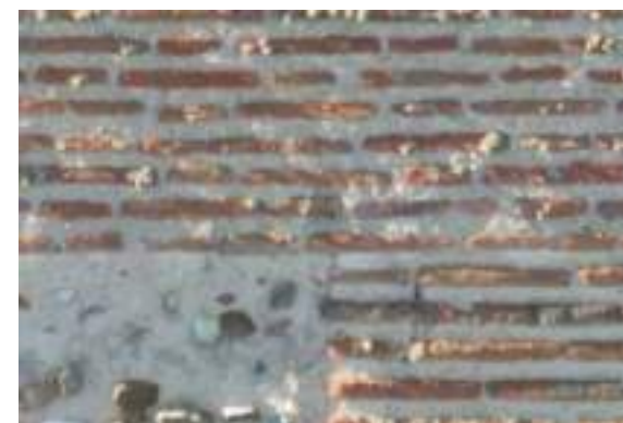
Fig. 69. Aparejo de ladrillo en la torre del homenaje de la fortaleza de Castronuevo, Ávila. Imagen del autor.
