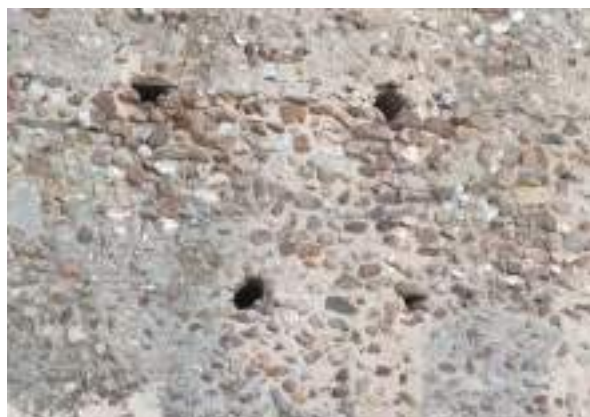
Fig. 74. Mechinales sobre el muro de tapia de cal y canto del recinto interior de la fortaleza de Castronuevo, Ávila. Imagen del autor.
