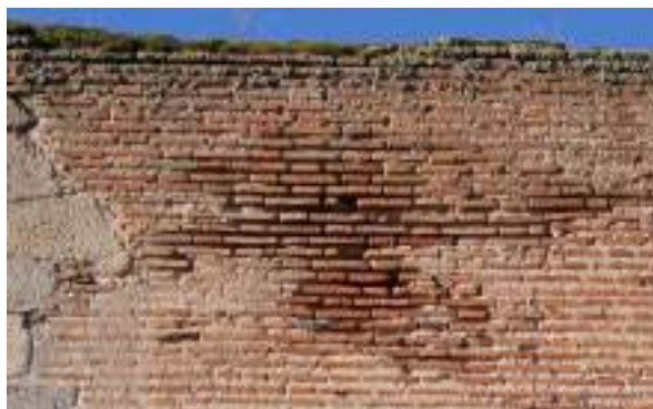
Fig. 98. Aparejo flamenco de la inacabada torre del homenaje de la fortaleza de Castronuevo, Ávila. Imagen del autor.
