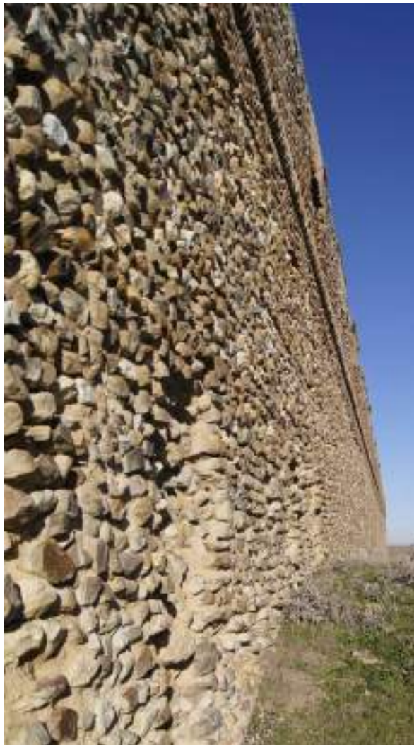
Fig. 80. Mampostería de rajuela del lienzo Este de la barrera artillera de la fortaleza de Castronuevo, Ávila. Imagen del autor.
