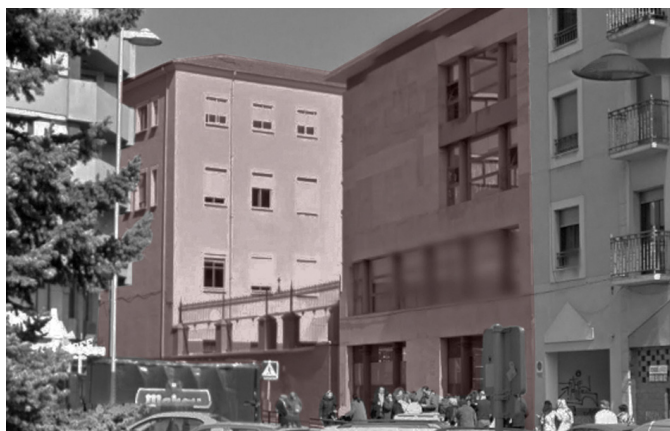
Fig. 55 Fachada del colegio hacia la plaza del Cuartel Viejo.
