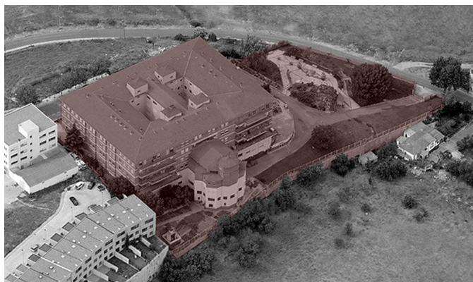
Fig. 312 Vista aérea posterior de la residencia en la actualidad.
