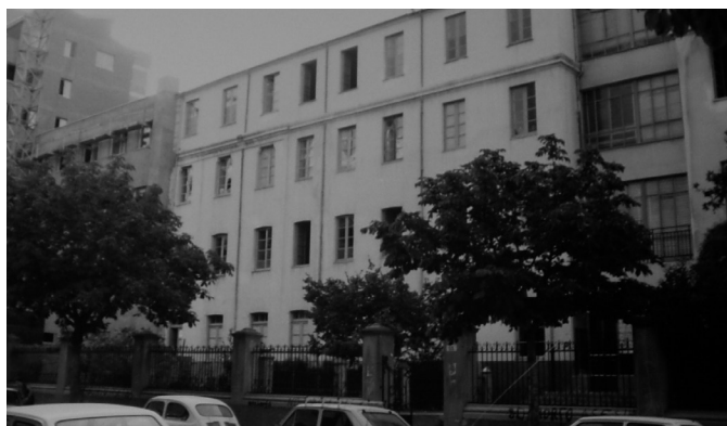
Fig. 128 Construcción de la ampliación occidental del colegio.
