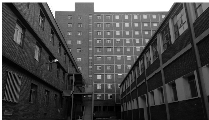
Fig. 237 Callejón actual entre la fachada norte y el gimnasio.
