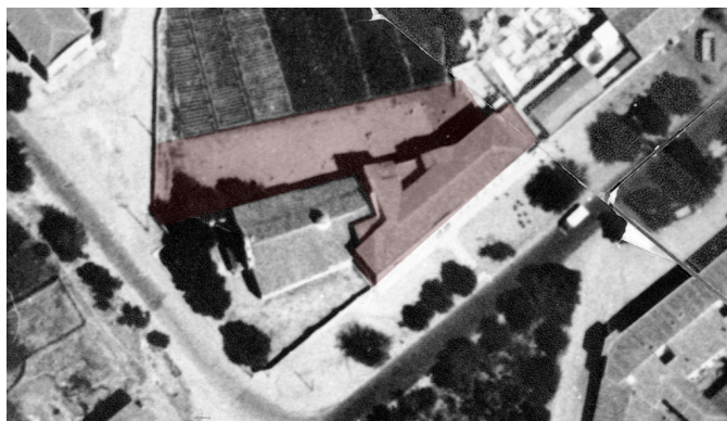
Fig. 59 Vista aérea del colegio San Vicente de Paúl en 1956.
