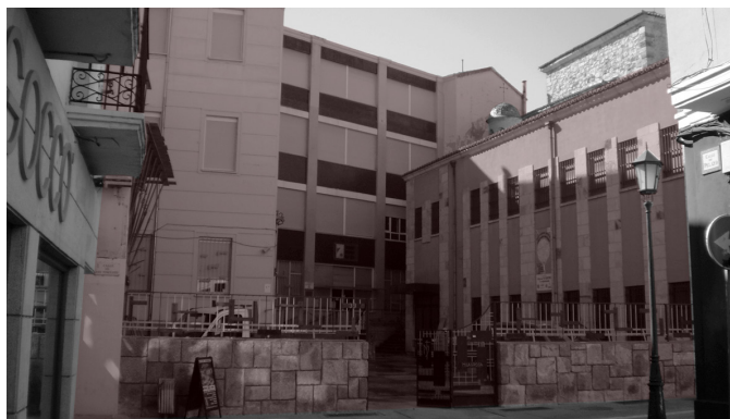
Fig. 53 Fachada del colegio hacia la calle San Torcuato.
