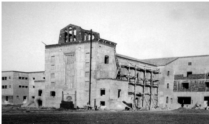
Fig. 34 Colegio Ntra. Señora del Tránsito en construcción. Años cuarenta.
