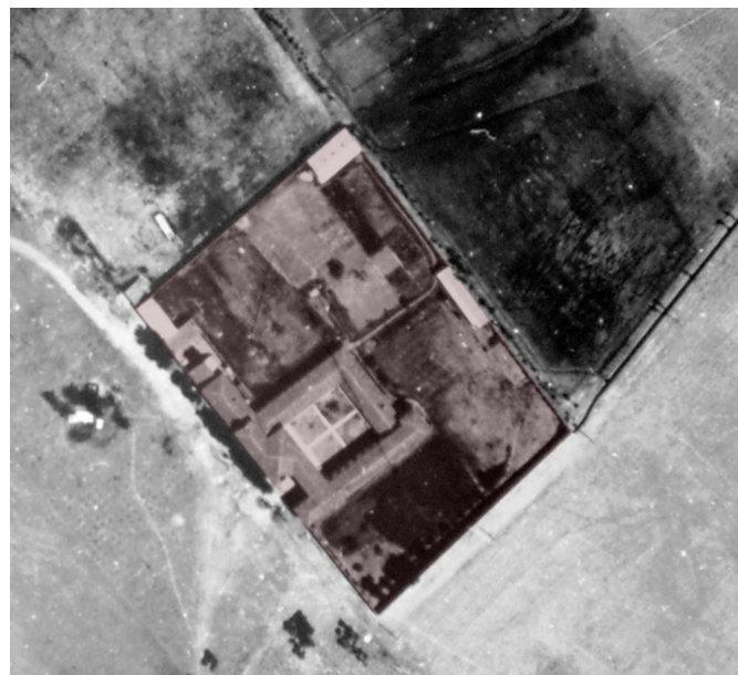
Fig. 244 Vista aérea del convento de la Asunción y San José en 1956.
