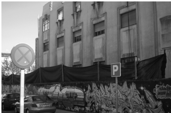
Fig. 291 Colegio menor parcialmente demolido.
