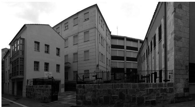
Fig. 43 Obras actuales del Colegio hacia la calle San Torcuato.
