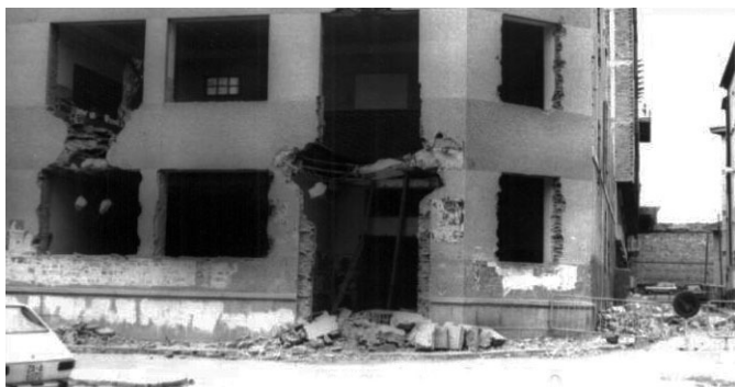
Fig. 179 Derribo del antiguo colegio Corazón de María.
