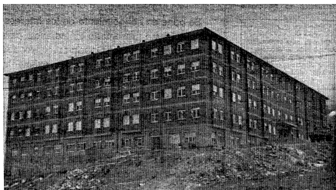
Fig. 309 Fachada principal de la residencia en 1976.
