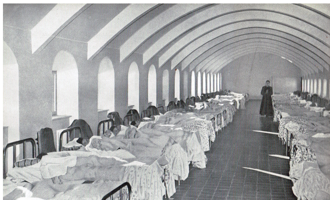
Fig. 231 Interior de uno de los dormitorios de los alumnos internos.
