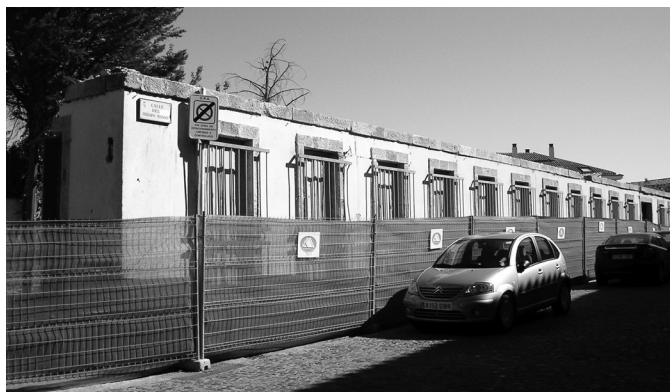
Fig. 191 Restos de la fachada principal en 2005.
