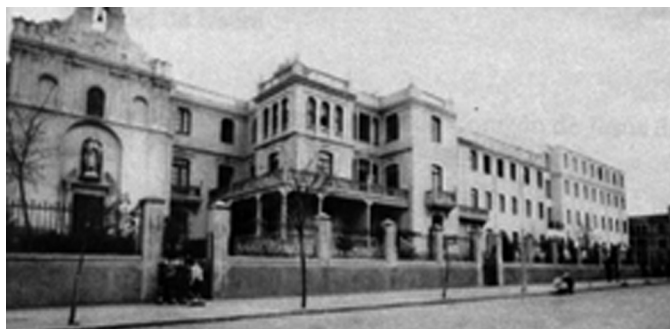
Fig. 127 Construcción de la ampliación oriental del colegio.
