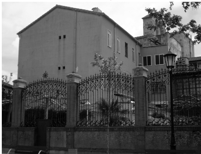
Fig. 156 Fachadas posteriores de la residencia.
