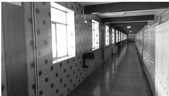
Fig. 240 Pasillo de aulas con el alicatado original en la actualidad.
