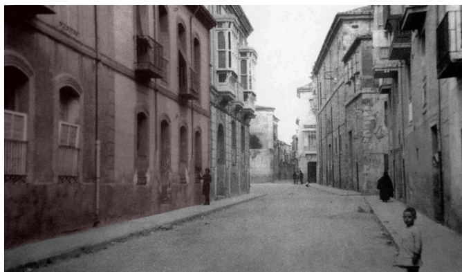
Fig. 108 Fachada a la calle de la Rúa de los Francos del colegio del Amor de Dios. Estaría compuesto por los inmuebles primero y segundo por la izquierda.
