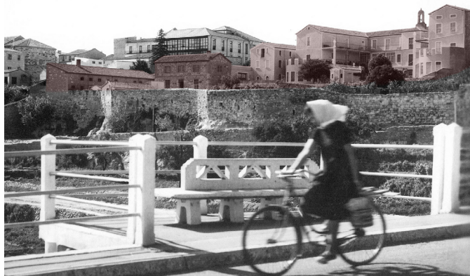
Fig. 71 Fachada posterior del asilo en los años cincuenta.
