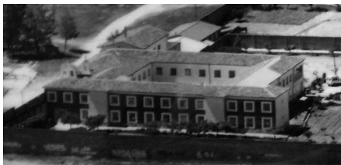
Fig. 253 Vista aérea del convento ya ampliado desde el sureste.
