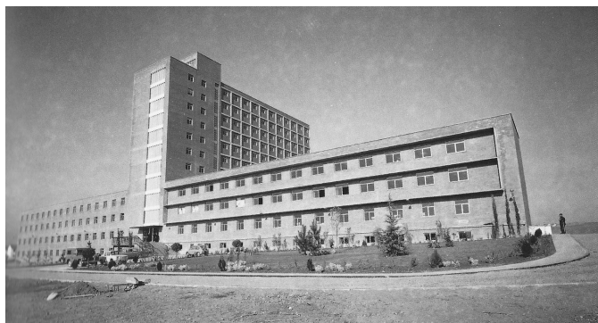
Fig. 236 Fachada principal del colegio «Rey Fernando». Años sesenta.
