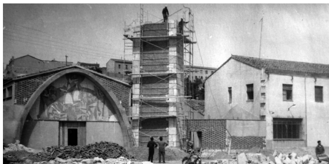
Fig. 273 Proceso de construcción de la torre de la capilla.
