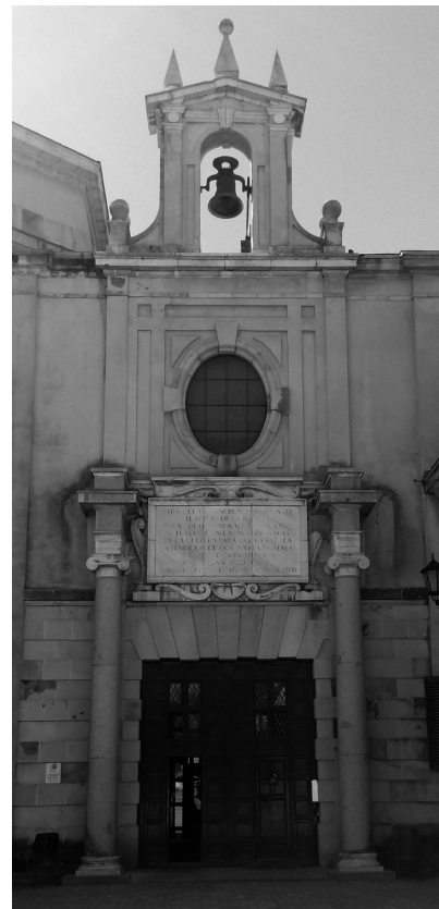
Fig. 218 Fachada de acceso a la Universidad laboral (desde el atrio).
