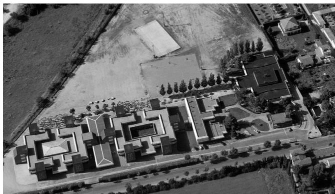
Fig. 180 Vista aérea actual del nuevo colegio Corazon de María.
