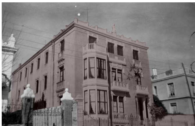
Fig. 200 Fachada principal de la residencia de la avda. Generalísimo.
