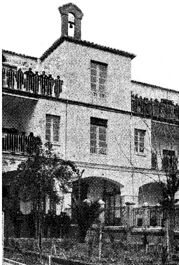
Fig. 65 Fachada al patio del asilo de ancianos en 1939.
