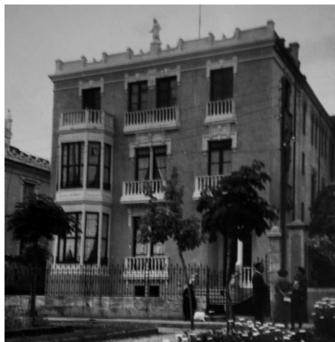
Fig. 198 Fachada principal de la residencia de la avda. Generalísimo.
