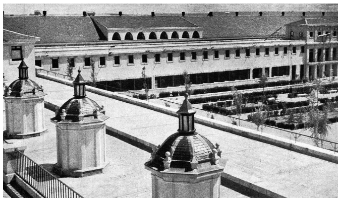
Fig. 230 Cubiertas de la Fundación San José tras su inauguración.
