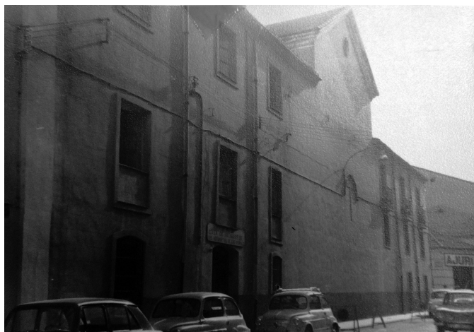
Fig. 308 Fachada del asilo de ancianos de la calle de San Pablo.
