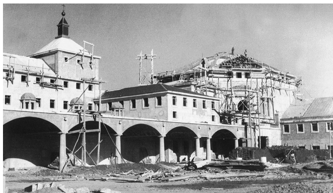
Fig. 214 Escuelas Profesionales «José Antonio Girón» en obras.
