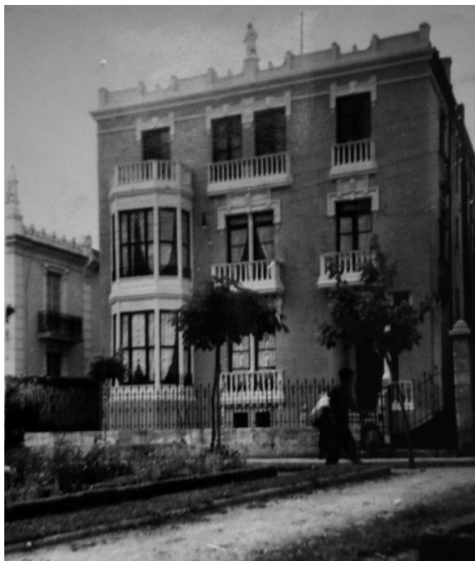
Fig. 204 Fachada principal de la residencia de la avda. Generalísimo.
