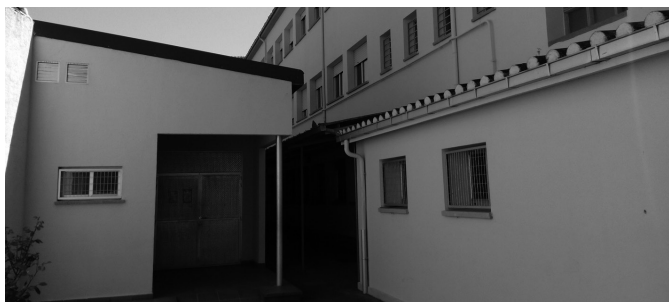
Fig. 145 Patio posterior y acceso al gimnasio del colegio.
