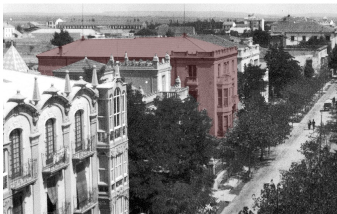
Fig. 201 Fachada principal de la residencia de la avda. Generalísimo.
