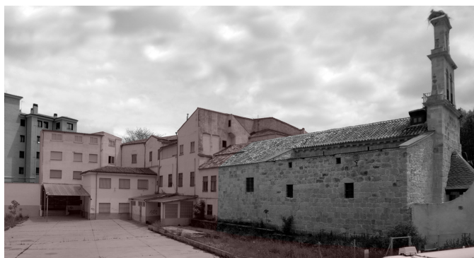
Fig. 61 Vista actual del patio del colegio San Vicente de Paúl.
