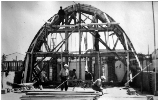
Fig. 272 Construcción de los arcos fajones parabólicos de la capilla.
