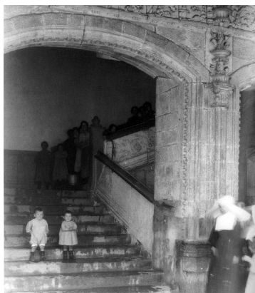
Fig. 23 Claustro y escalera principal del Hospicio Provincial.
