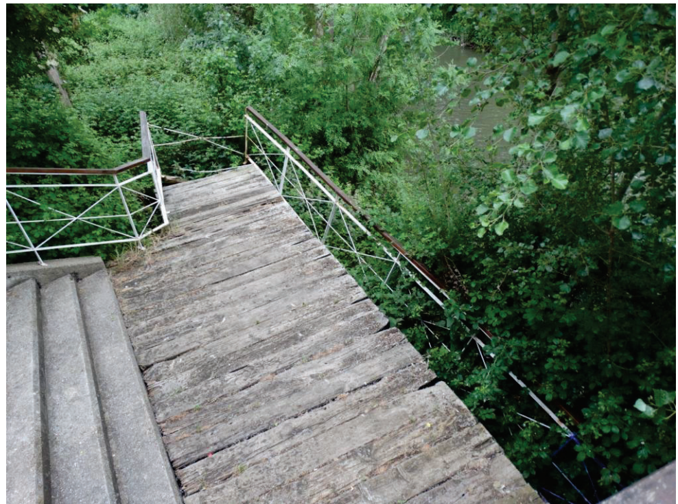
Mirador 2 hacía el río en parque “Isla Dos Aguas”. Barandilla desenganchada y suelo inestable. Eduardo Aguado
