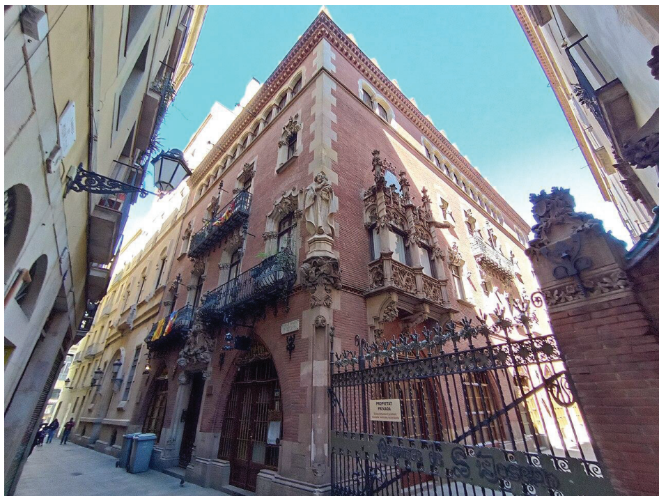
Fig. 19: Josep Puig i Cadafalch, fachada de la Casa Martí (1896). Barcelona.
