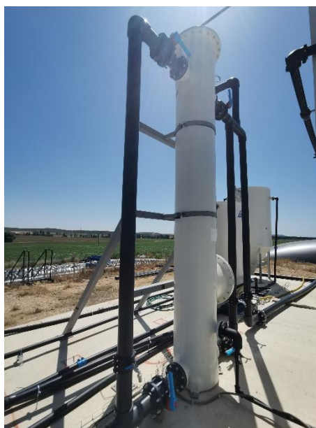
Figura 17. Columna de absorción.
