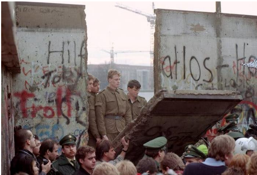
Imagen 24. Civiles y militares demoliendo el Muro
