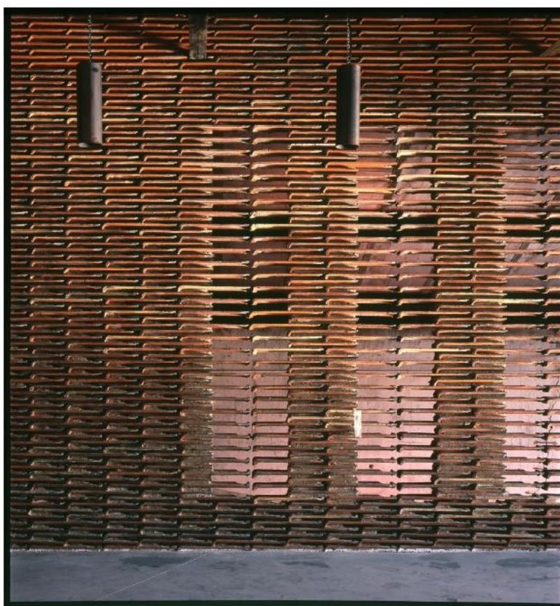
Reutilización de tejas en la Nave 8B del Matadero de Madrid
