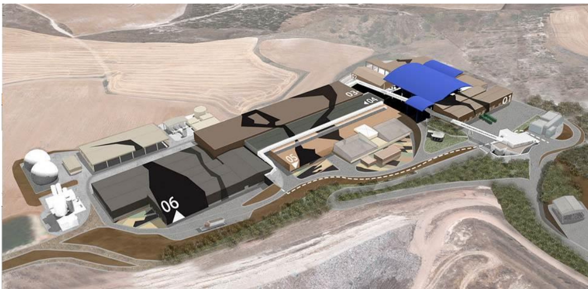
OBRAS DE AMPLIACIÓN Y MODERNIZACIÓN DEL CTR DE VALLADOLID
