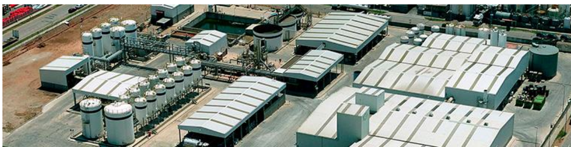
PLANTA DE TRATAMIENTO DE RESIDUOS DE FCC
