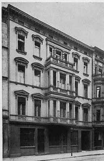
Das Gebäude vor dem Umbau
