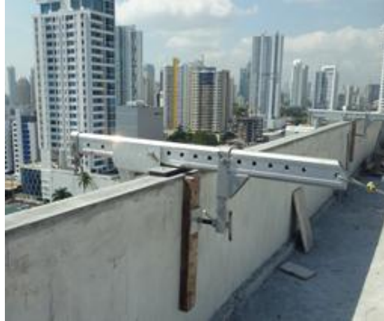
Figura 10 Sistema de parapeto instalado en muro perimetral (propia)
