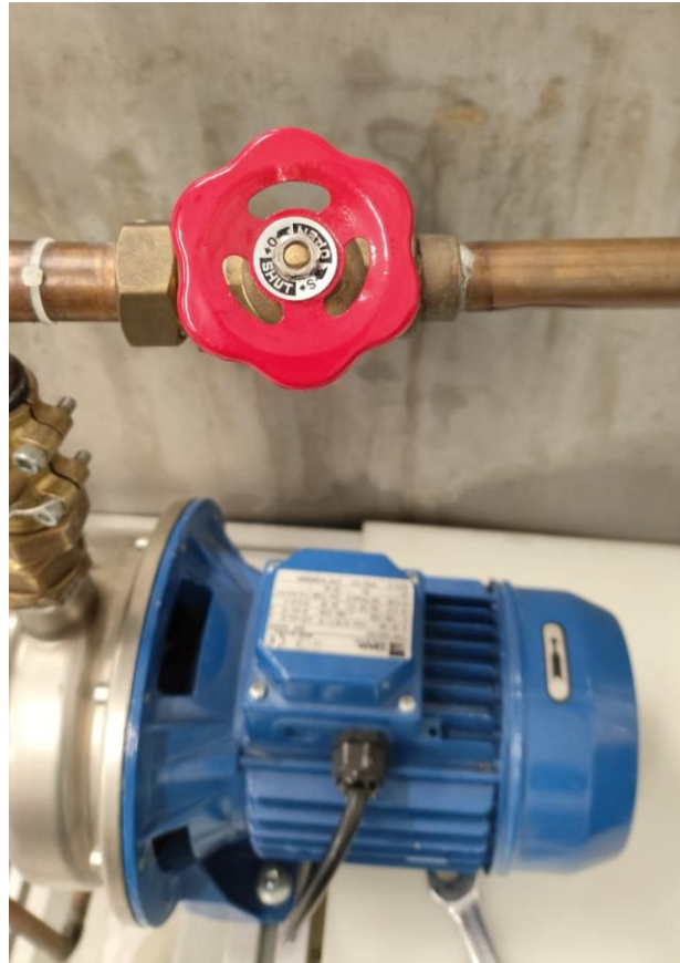
Ilustración 10. Válvula de regulación de caudal
