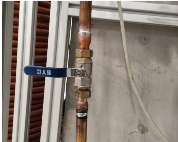
Ilustración 8. Válvula de corte
