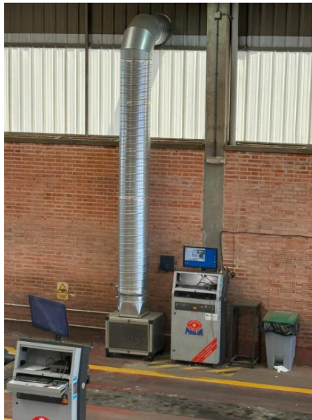
Figura 6. Ejemplo de sistema de extracción localizada instalado en la ITV del Grupo Itevelesa en el Polígono de San Cristóbal, Valladolid. Elaboración propia
