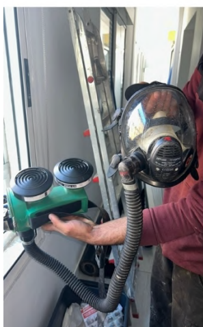
Ilustración 14. Relación de EPI obligatorios para trabajos de desamiantado. Fuente: elaboración propia, fotografías tomadas durante una visita de inspección de ejecución de trabajos de desamiantado.
