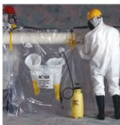
Ilustración 15. Procedimiento de trabajo con sacos con guantes: glove-bag. Fuente: elaboración propia.
