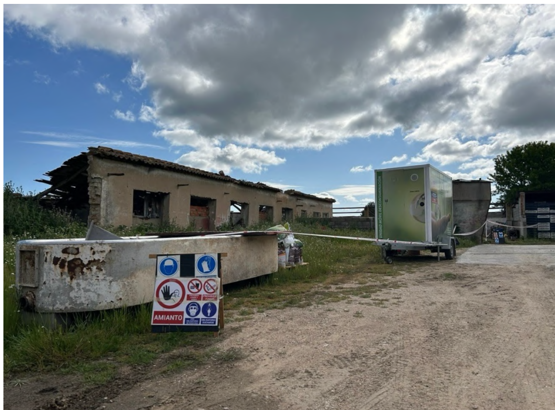
Ilustración 9. Ejemplo de señalización de zona de trabajos de desamiantado en la zona de almacenamiento de residuos. Fuente: visita a obra.
