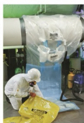
Ilustración 15. Procedimiento de trabajo con sacos con guantes: glove-bag. Fuente: elaboración propia.
