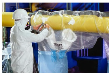
Ilustración 15. Procedimiento de trabajo con sacos con guantes: glove-bag. Fuente: elaboración propia.
