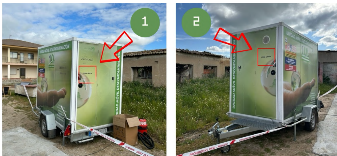
Ilustración 13. Unidad móvil de descontaminación con tres compartimentos. Fuente: elaboración propia, fotografías tomadas durante una visita de inspección de ejecución de trabajos de desamiantado.
