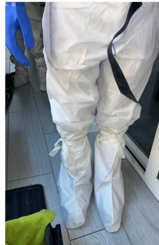
Ilustración 14. Relación de EPI obligatorios para trabajos de desamiantado. Fuente: elaboración propia, fotografías tomadas durante una visita de inspección de ejecución de trabajos de desamiantado.
