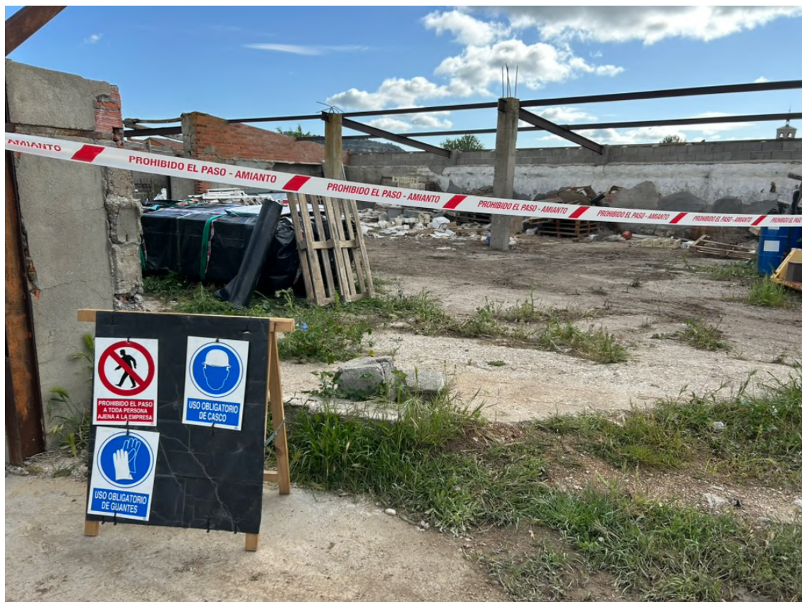
Ilustración 8. Ejemplo de señalización de zona de trabajos de desamiantado. Fuente: visita a obra.
