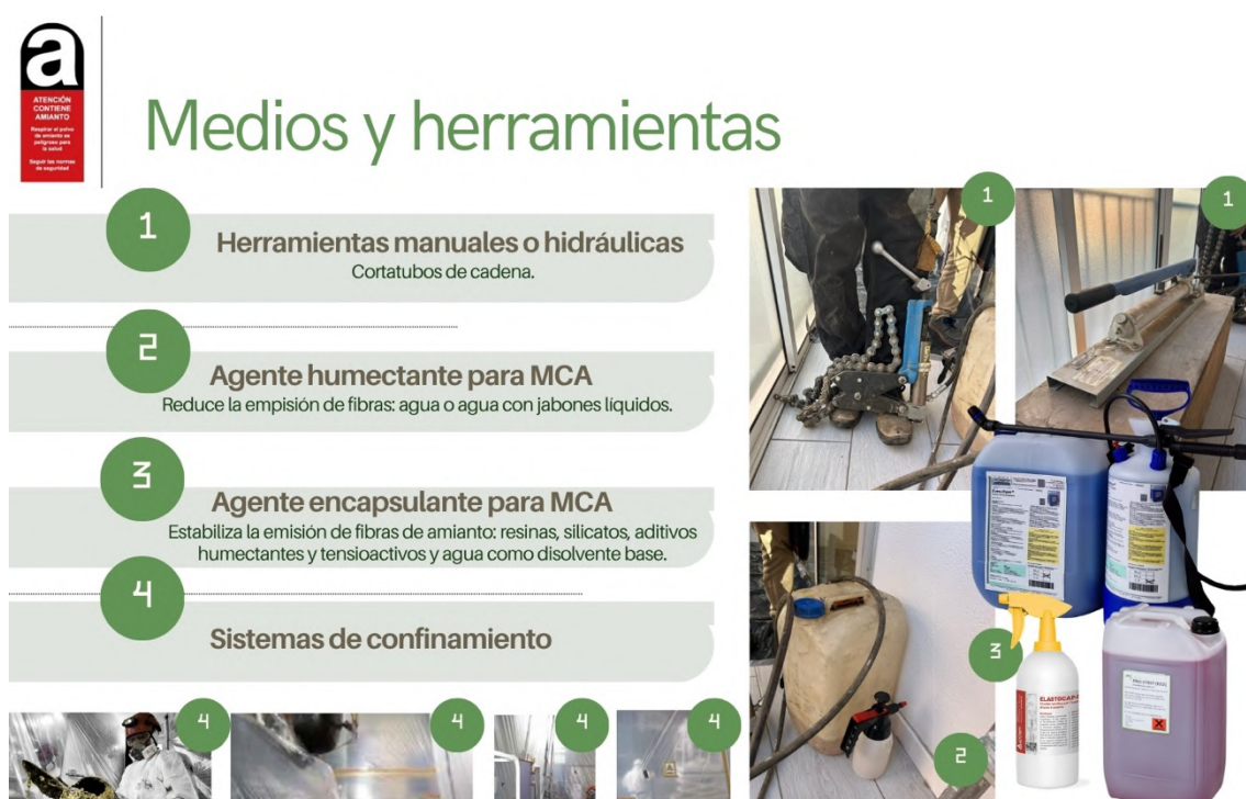
Ilustración 10. Listado no exhaustivo de medios y herramientas empleadas en trabajos de desamiantado. Fuente: elaboración propia, visita a obra.
