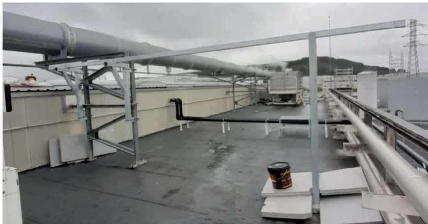
Ilustración 40 Fotografía de soporte instalado por operario de la empresa instaladora (Operario, 2023)
