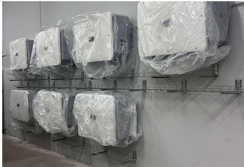
Ilustración 35 Fotografía de inversores Huawei instalados por operario de la empresa instaladora (Operario, 2023)
