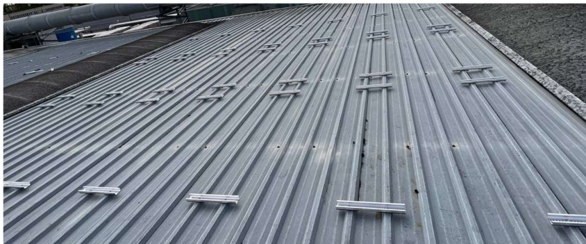
Ilustración 38 Fotografía de las guías instaladas por operario de la empresa instaladora (Operario, 2023)
