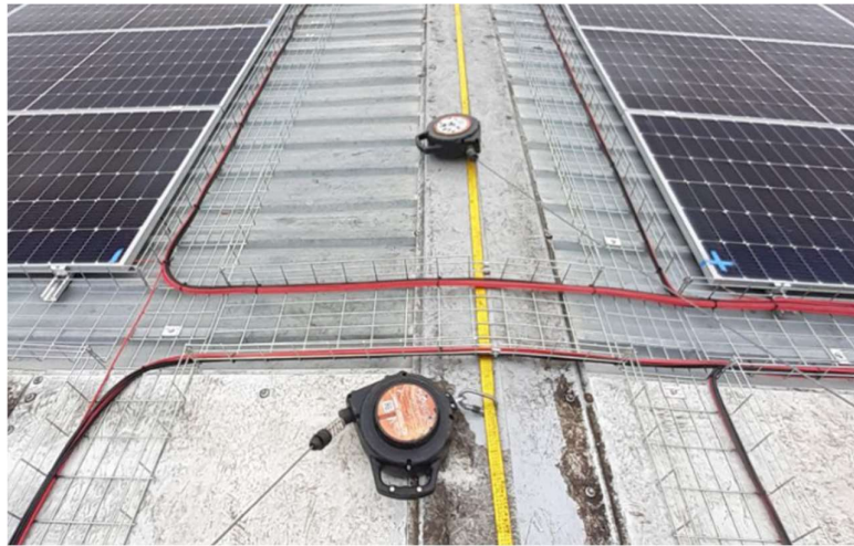
Ilustración 36 Fotografía de cableado y rejiband en la cubierta de la nave por operario. (Operario, 2023)
