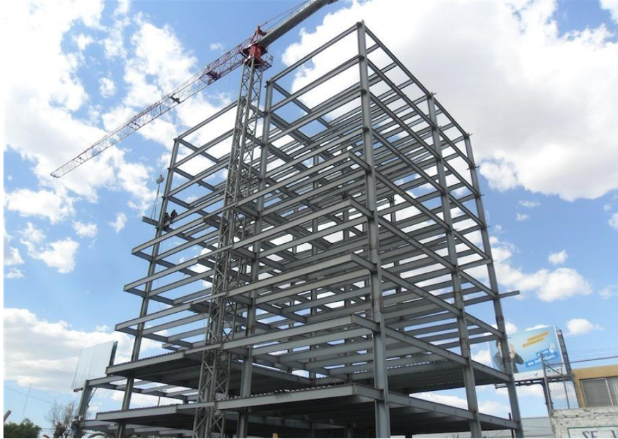
Figura 27: Ejemplo pórtico de edificación
