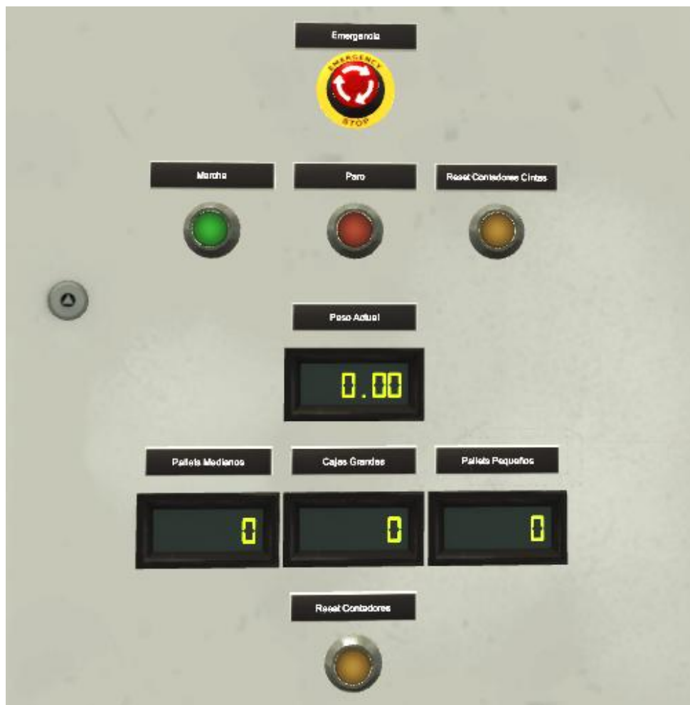
Figura 102. Vista cuadro eléctrico. Escena colocador por peso
