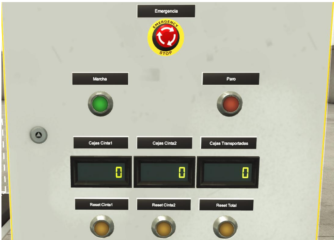
Figura 54. Vista cuadro eléctrico. Escena cinta transportadora
