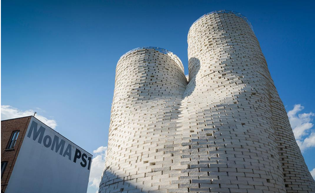
Figura 4. Pabellón Hy-Fi construido con bloques de micelio. Nueva York, EE. UU., 2014.
