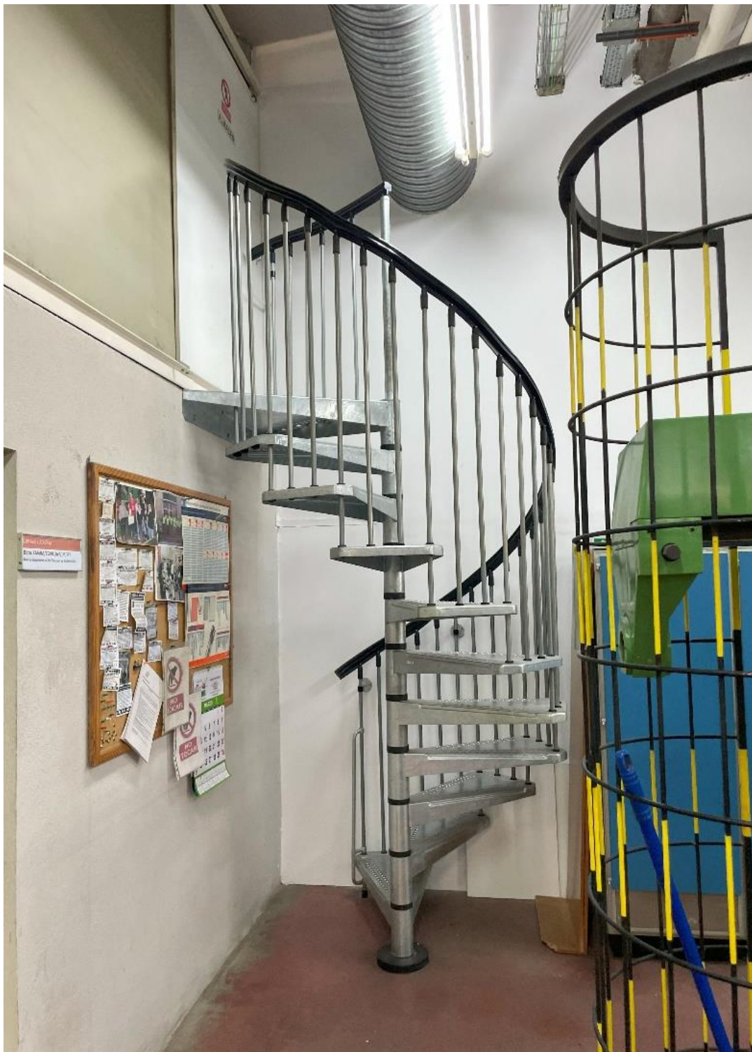
Ilustración 11: Escalera de caracol
