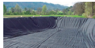
Fig. 153 Ejemplo de instalación de geotextil.
