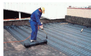
Fig. 152 Instalación de una lámina asfáltica en un tejado.
