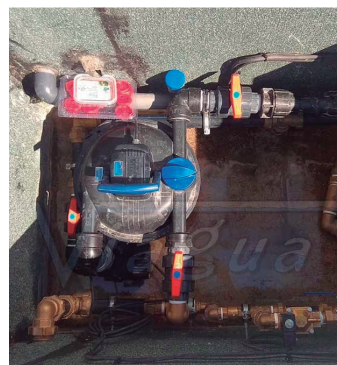
Fig. 194 Arqueta de filtro. Fuente Helicoidal en Palacio de Villagonzalo, Madrid
