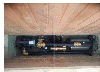
Fig. 184 Bomba de filtro y bomba del juego de agua. Fuente de Fuensalida, Madrid.
