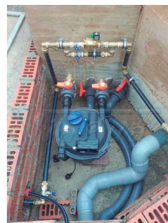
Fig. 193 Arqueta del filtro. Fuente de Fuensalida, Madrid.
