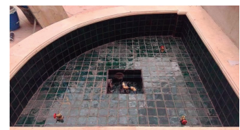
Fig. 182, 183 Arqueta de la bomba antes y después del recubrimiento. Fuente Helicoidal en Palacio de Villagonzalo, Madrid
