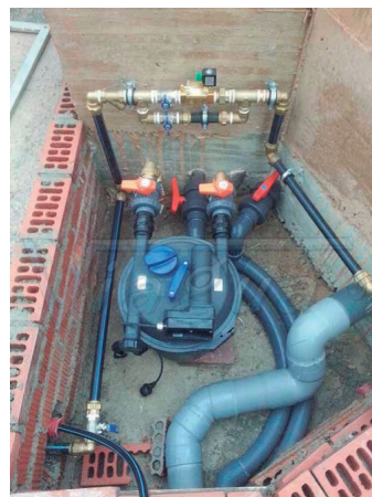
Fig. 193 Arqueta del filtro. Fuente de Fuensalida, Madrid.
