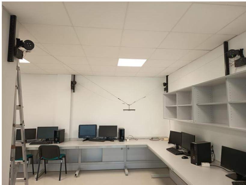
Figura 35. Montaje completo del sistema Spydercam
