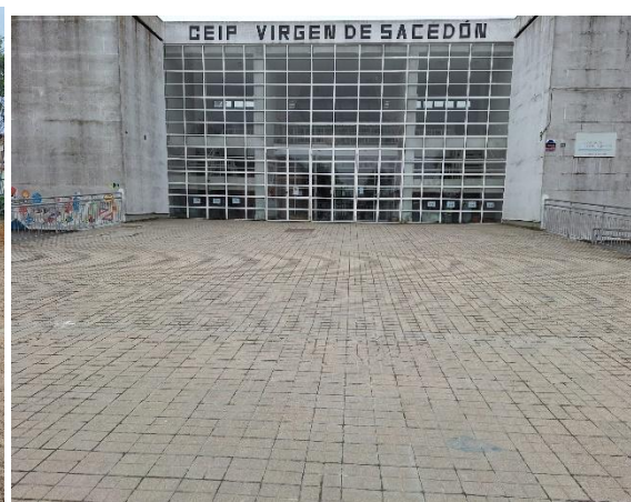
Imagen 9. Cemento Entrada. Autoría Propia.
