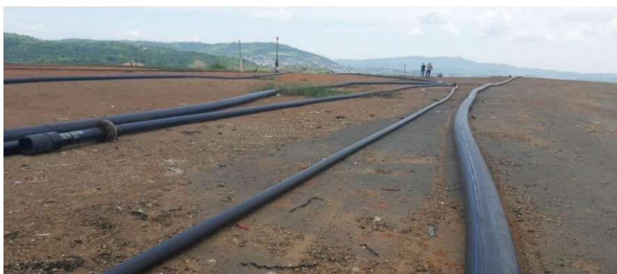
Imagen 1. Tubería que conecta con los pozos para el transporte de biogás
