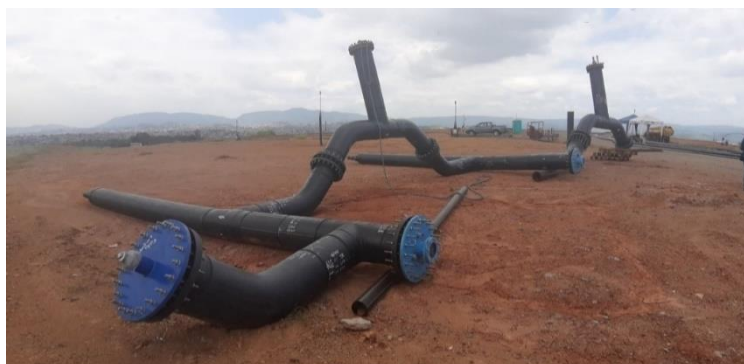
Imagen 2. Tubería y sub-cabezales para el sistema de captación de biogás
