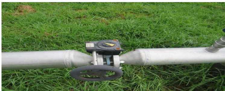
Imagen 4. Medidor de conducción de biogás en operación relleno sanitario de Pichacay
