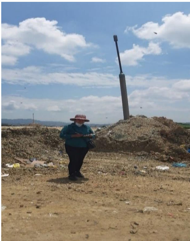
Imagen 15. Chimenea de biogás relleno sanitario Las Iguanas
