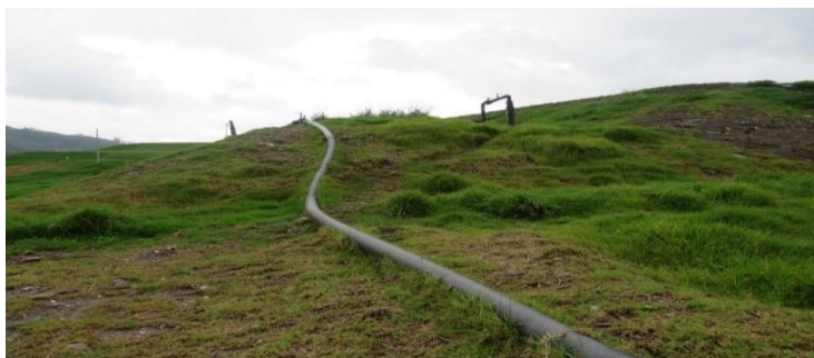
Imagen 3. Tubería y válvula de conducción de biogás relleno sanitario de Pichacay
