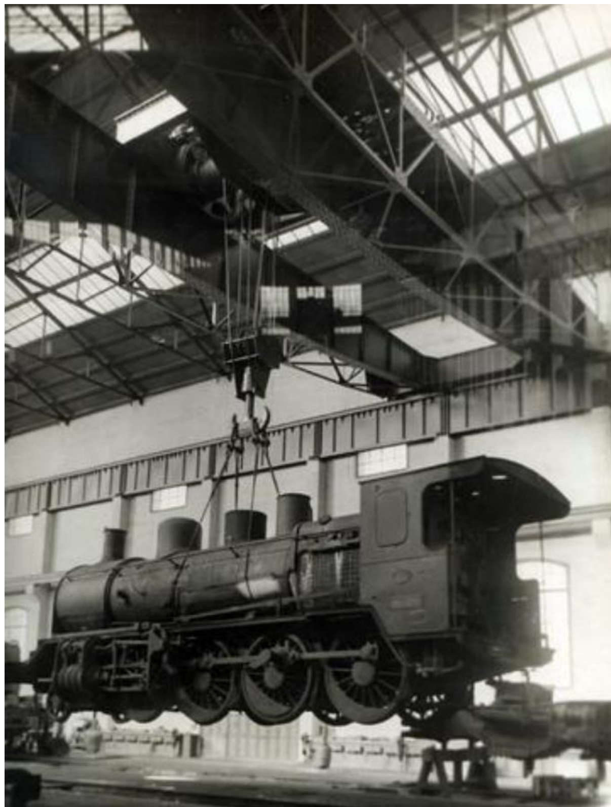
FIG. 63 Vista lateral del montaje de una locomotora de vapor, suspendida y transportada por un puente grúa. (Docutren, 1950)
