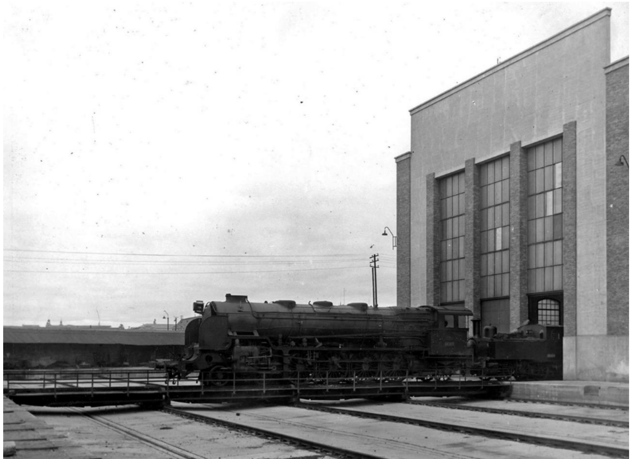
FIG. 60 Carro transbordador para locomotoras, Talleres de Valladolid, ca1950 NOTA: La locomotora está entrando al taller de Montaje, por lo que, puesto que para poder trabajar sobre ella ha de estar fría, necesita ser remolcada por una locomotora de maniobras. (Lalana, 2021)
