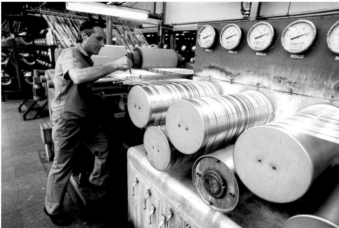
FOTO 10 BANCO DE POLIÉSTER. Operación de colocado de las hebras en el peine.
