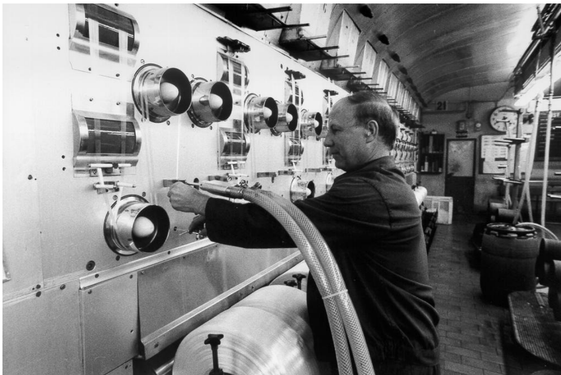
FOTO 5 BOBINADORAS DE LA FÁBRICA INDUSTRIAL. Operación de corte.
