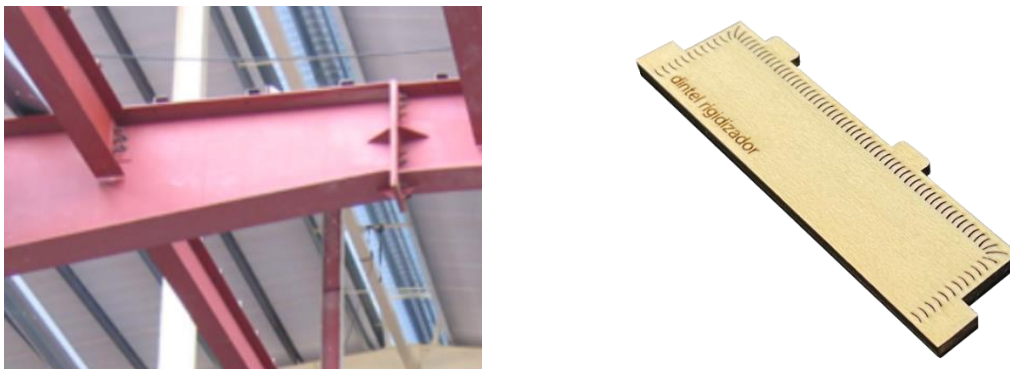
Figura 2.26. Comparativa entre rigidizador en el dintel real (izquierda) [15] y en el modelo físico (derecha).
