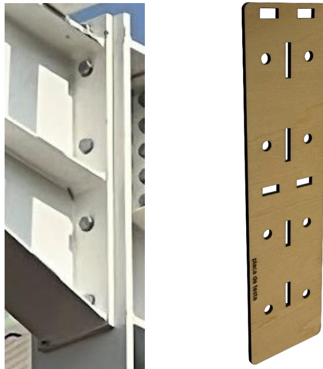
Figura 2.17. Comparativa entre placa de testa real (izquierda) y modelo físico (derecha).
