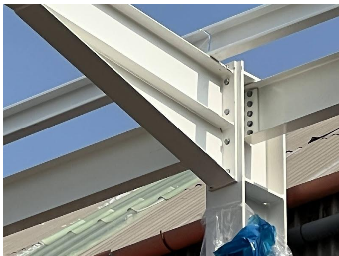
Figura 2.15. Unión atornillada pilar-dintel en la realidad.
