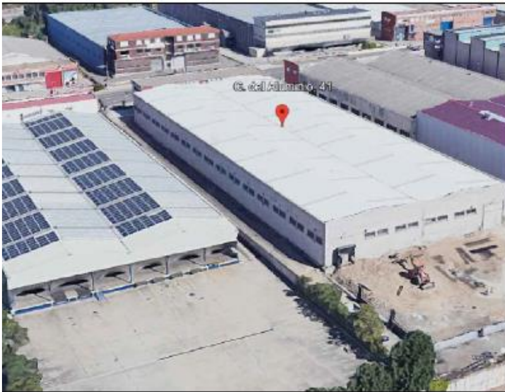
Figura 6. Cubierta de la nave sobre la que se colocaran los módulos fotovoltaicos.
