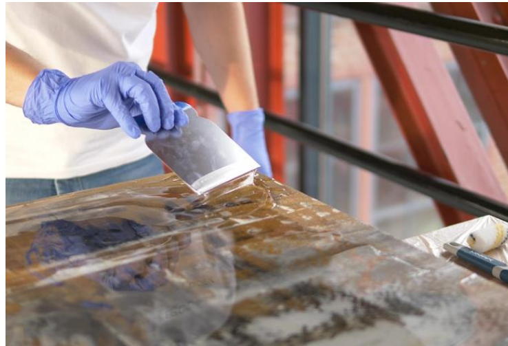
Ilustración 26. Recubrimiento con resina epoxi.
