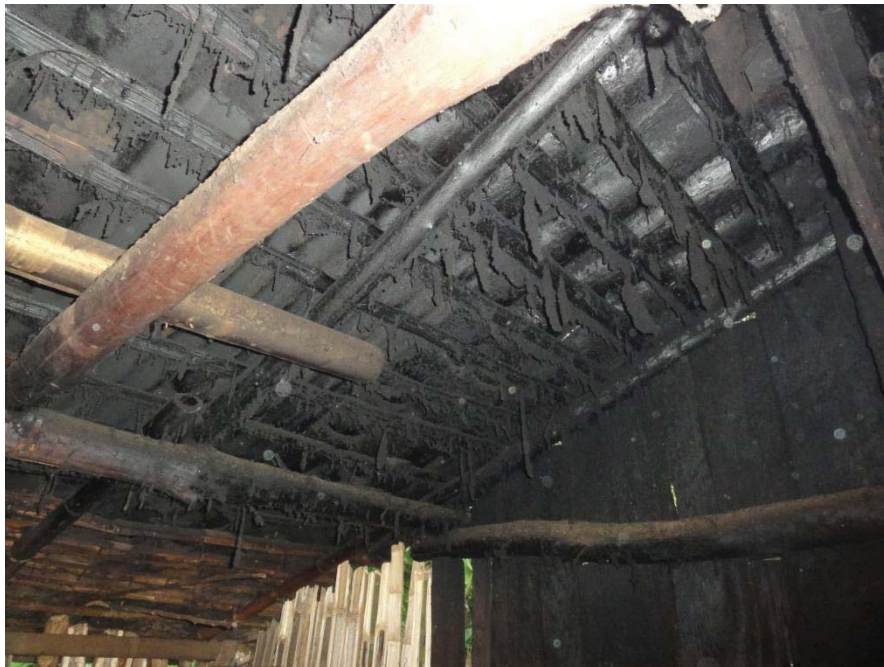
Figura 1. Cocinas de la comunidad
