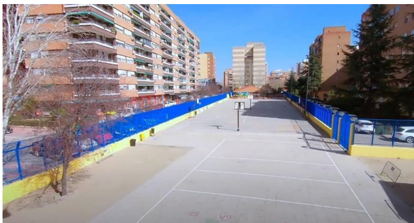
FIGURA 4. Patio del CEIP Cristóbal Colón, Alcalá de Henares
