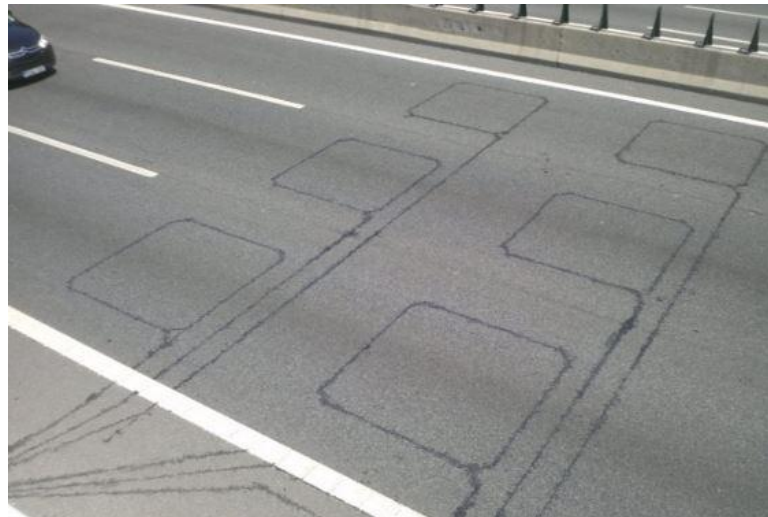
Ilustración 8 Toma de datos mediante espiras
