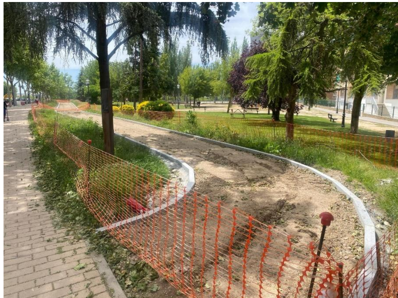
Ilustración 32 Carril bici en construcción parque León Felipe Zamora;
