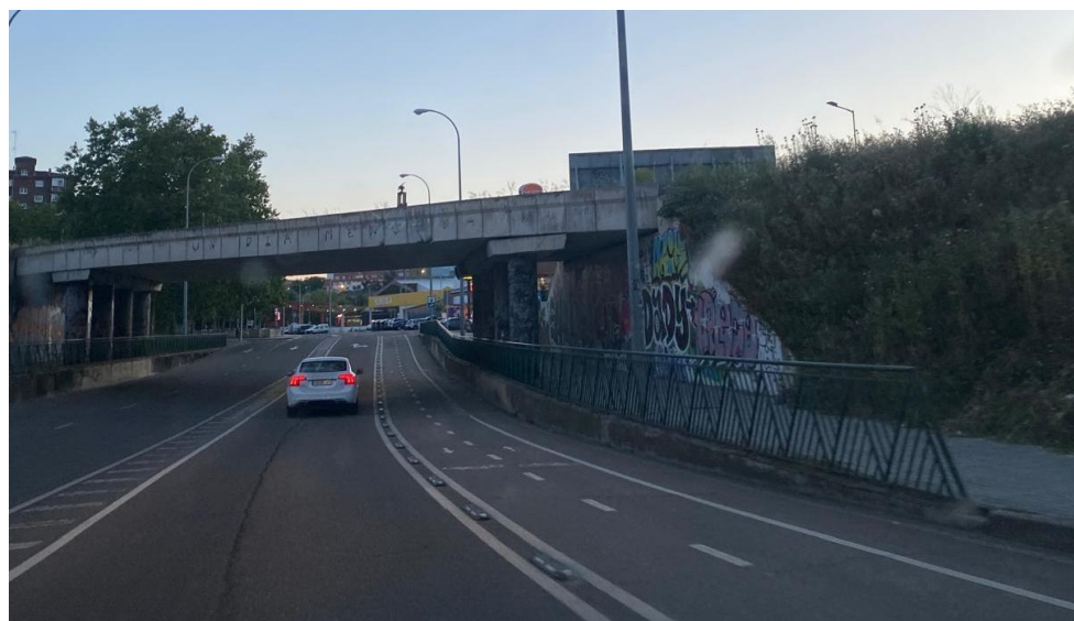
Ilustración 31 Carrilbici de la Carretera Villalpando, Zamora;
