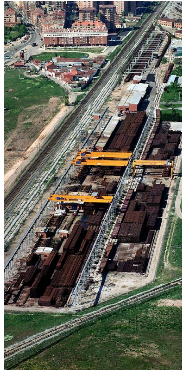
Figura 2 Imagen aérea de las instalaciones de REDALSA en Argales. Fuente: Web oficial de REDALSA
