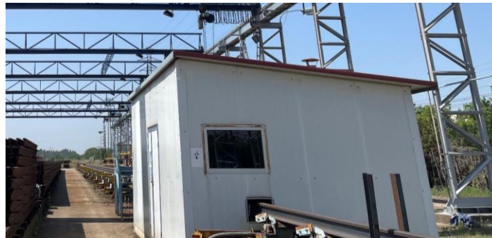
Figura 7 Zona de colocación de carriles en la línea (sup. izq.). Máquina con rodillos metálicos para preparación de extremos de carril (sup. dcha.). Instalación donde se encuentra la máquina anterior (inf.) Fuente: Propia
