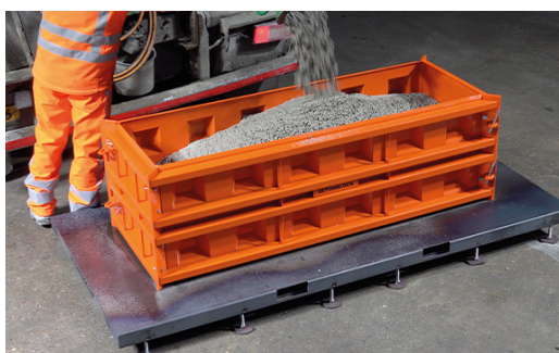
Fig. 141: Vertido de Hormigón en un molde
