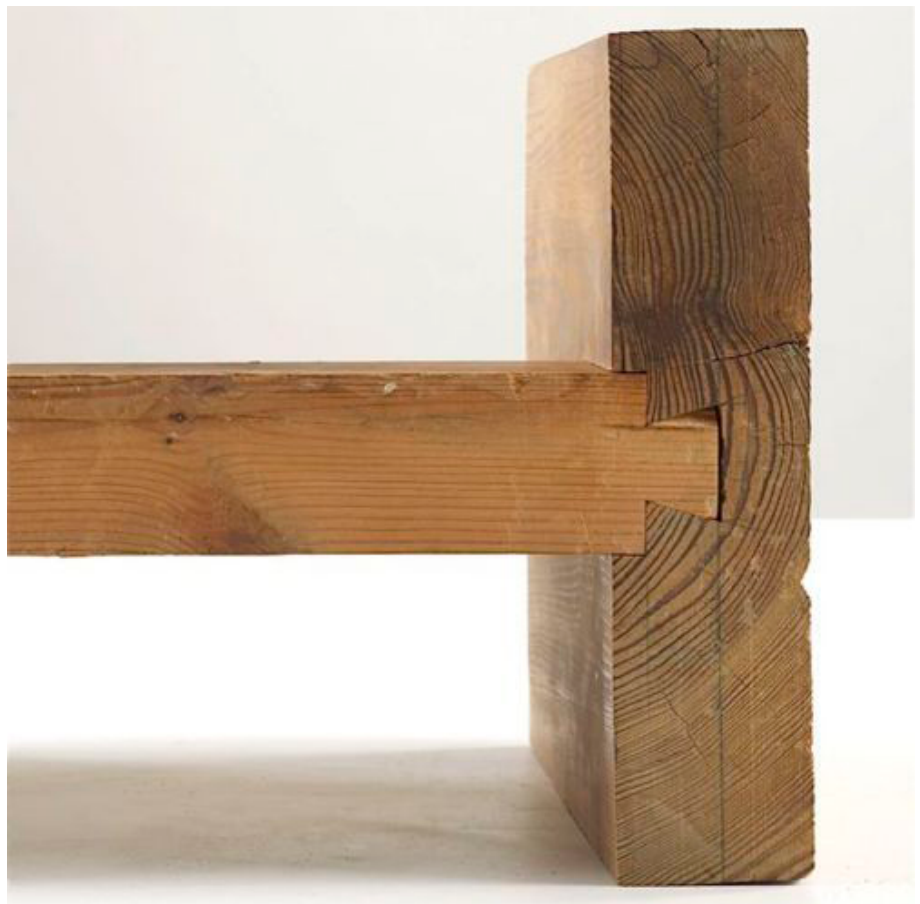
► Fotografía de una unión por cola de milano.
