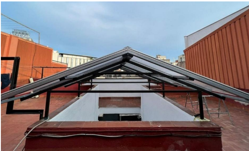
Figura 3: Cubierta a dos aguas [5]
