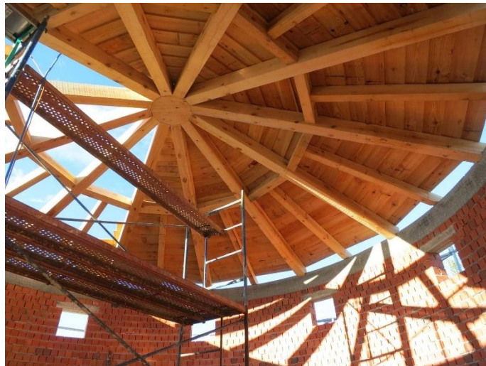
Figura 7: Estructura de madera en tejado cónico, Cantalejo (Segovia) [9]
