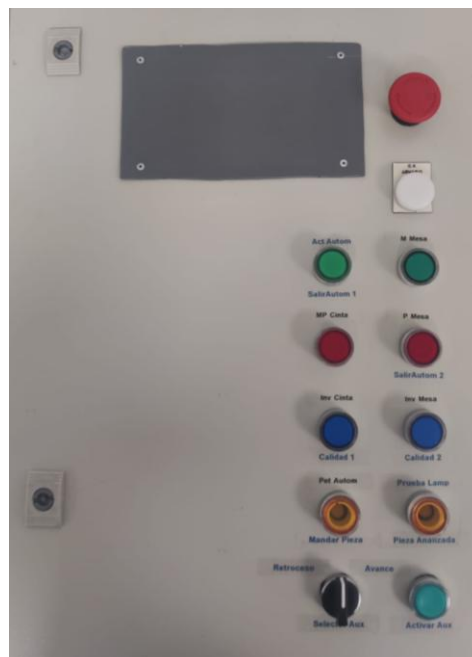
FIGURA 55: FRONTAL DEL ARMARIO CON BOTONERA ROTULADA
