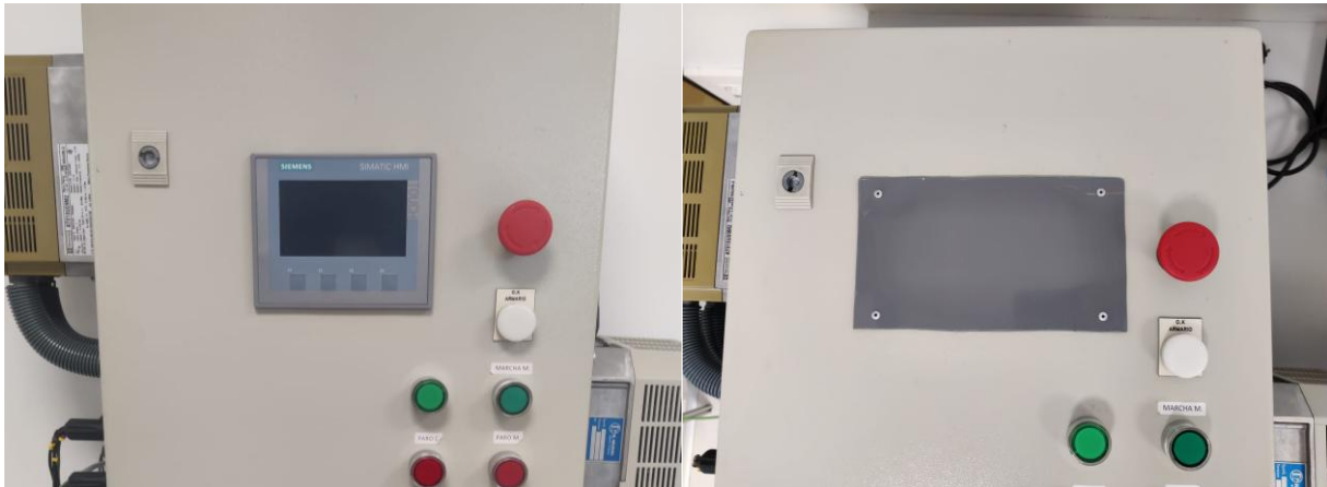
FIGURA 18: ANTIGUO HMI KPT 400 Y HUECO DE LA PANTALLA CEGADO
