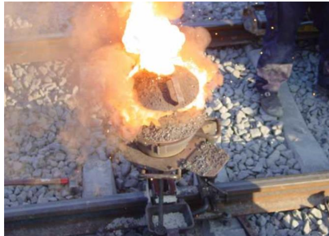
Ilustración 9 – Soldadura aluminotérmica, reacción en proceso. (18)
