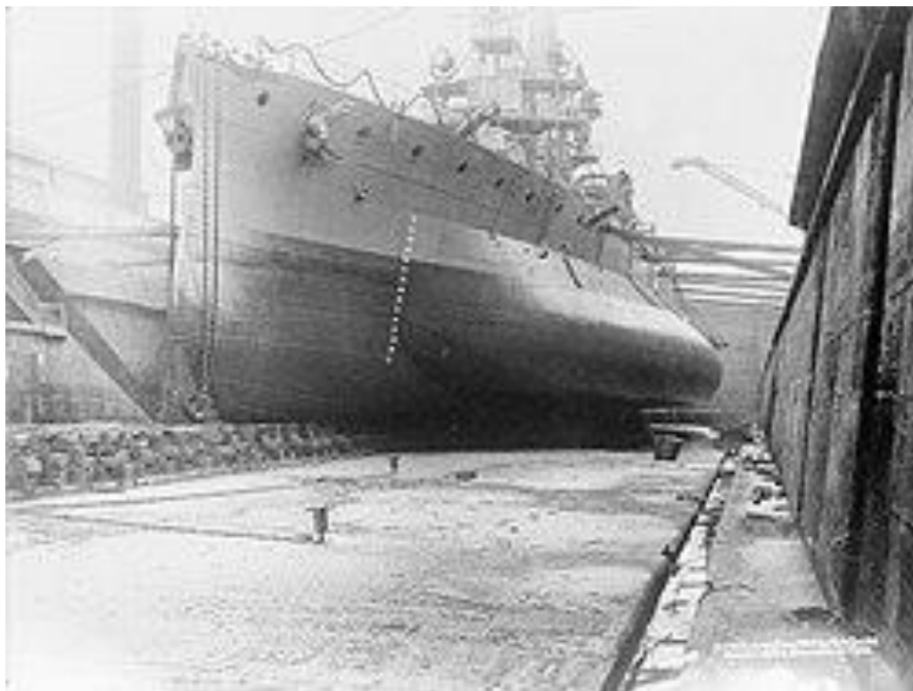
Ilustración 36 – Bulge antitorpedo del HMS Glatton, aproximadamente 1916. (135)
