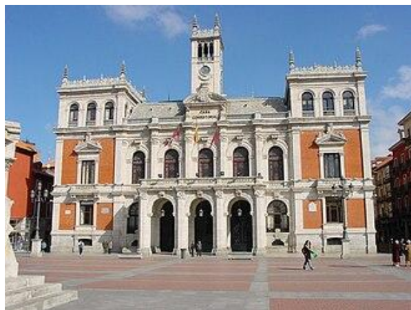
Casa consistorial de Valladolid
